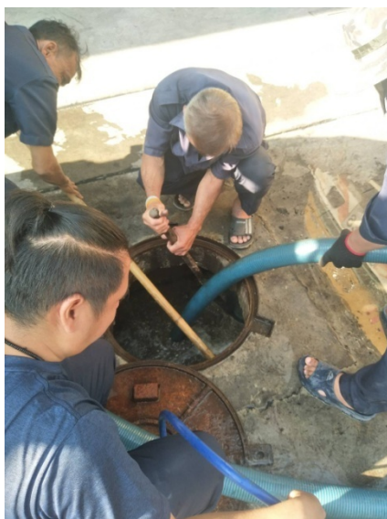
ภาพที่ 3-25 คูตะกอนในระบบบำบัดน้ำเสียและบำรุงรักษาระบบบำบัดน้ำเสียของโครงการ
