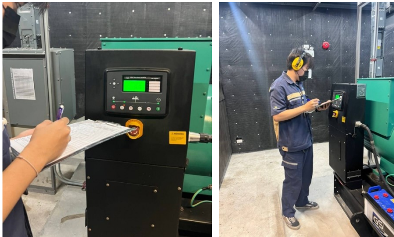
ภาพที่ 3-32 ตรวจสอบระบบไฟฟ้าสำรองฉุกเฉินของโครงการทุกสัปดาห์
