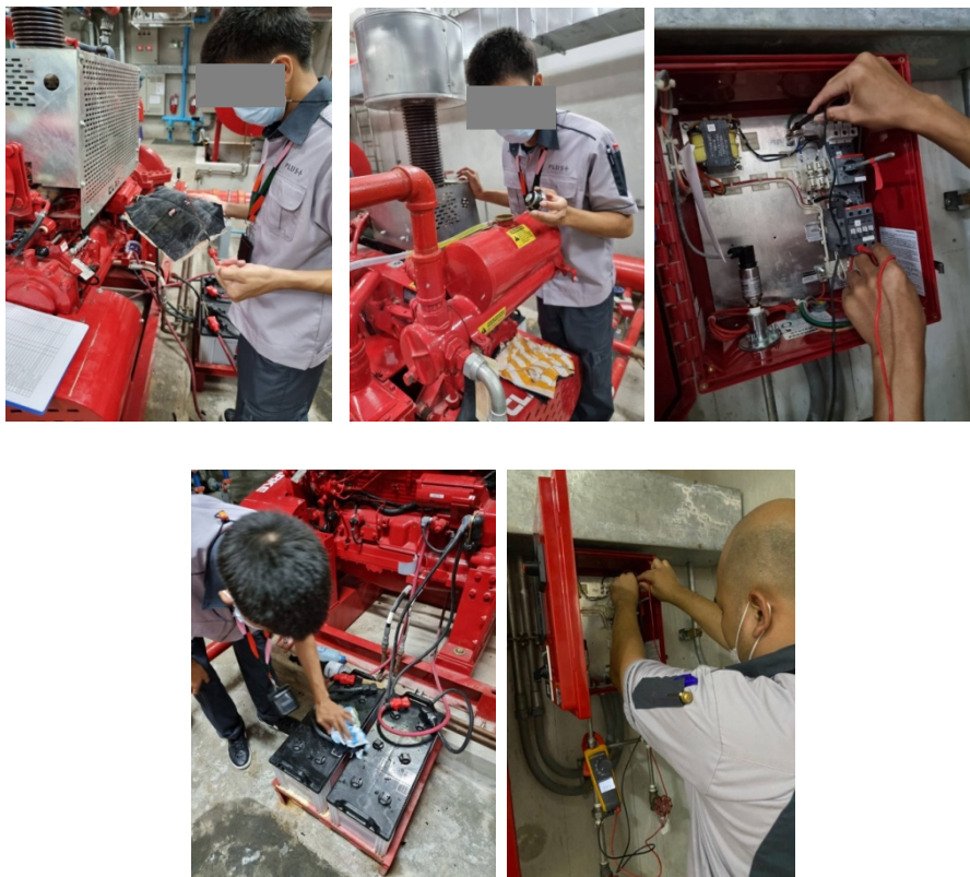
ภาพที่ 4-37 การตรวจสอบระบบ Fire Pump
