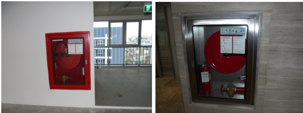
ภาพที่ 4-20 ตู้เก็บสายฉีดน้ำดับเพลิงพร้อมอุปกรณ์
