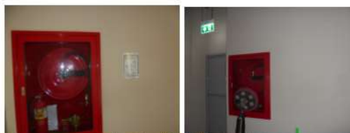
ภาพที่ 3-18 ท่อขึ้นและตู้เก็บสายฉีดน้ำดับเพลิงและอุปกรณ์
