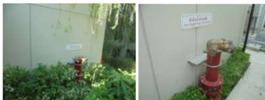
ภาพที่ 3-19 หัวฉีดน้ำดับเพลิงจากภายนอก
