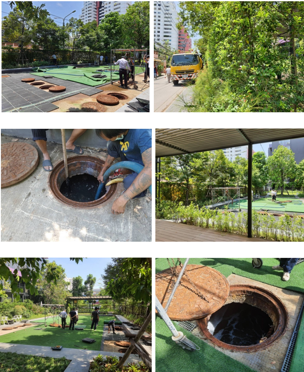
ภาพที่ 5-31 คูตะกอนที่บ่อเก็บตะกอนของระบบบำบัดน้ำเสีย
