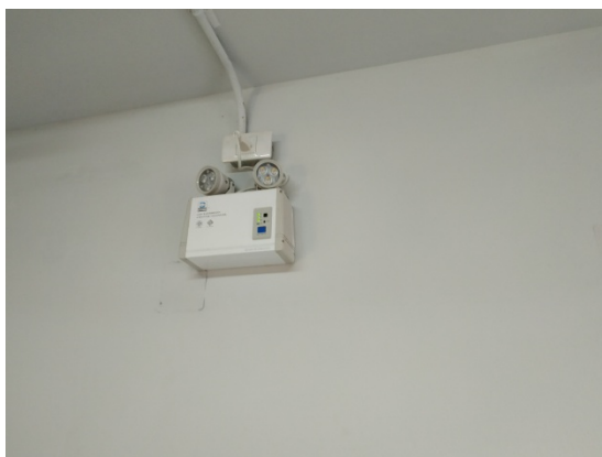
ภาพที่ 5-29 ไฟฟ้าส่องสว่างฉุกเฉิน และหัวรับน้ำดับเพลิงจากภายนอก
