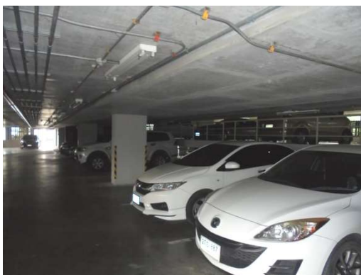
ภาพที่ 5-5 ช่องเปิดระบายอากาศของอาคารจอดรถ
