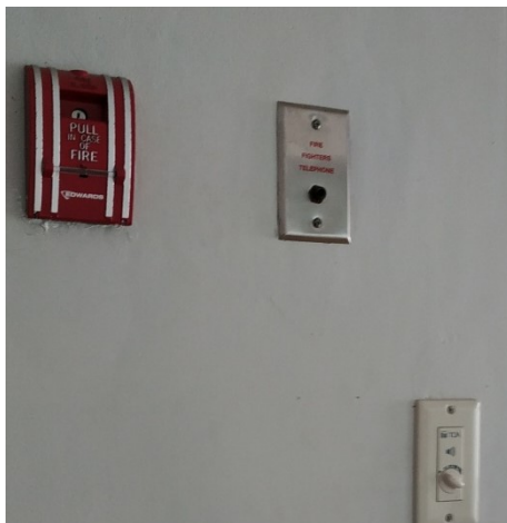
ภาพที่ 5-26 อุปกรณ์ป้องกันและเตือนอัคคีภัย
