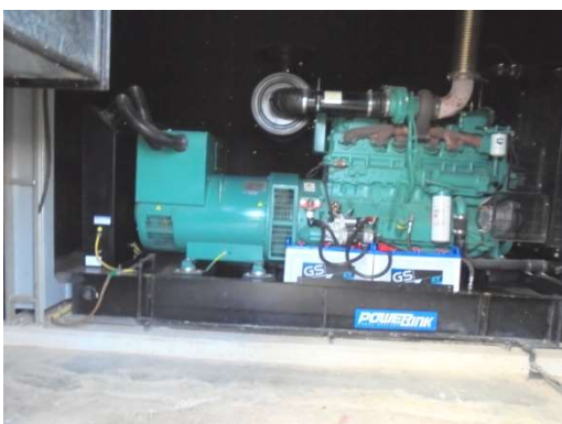
ภาพที่ 3-32 เครื่องกำเนิดไฟฟ้าฉุกเฉิน มีฉนวนกันเสียงดังอยู่ในห้อง
