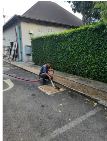
ภาพที่ 3-45 ล้างทำความสะอาดท่อระบายน้ำ ให้การระบายน้ำดี ไม่มีขยะอุดตัน
