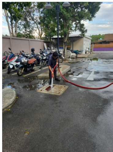
ภาพที่ 3-45 ล้างทำความสะอาดท่อระบายน้ำ ให้การระบายน้ำดี ไม่มีขยะอุดตัน
