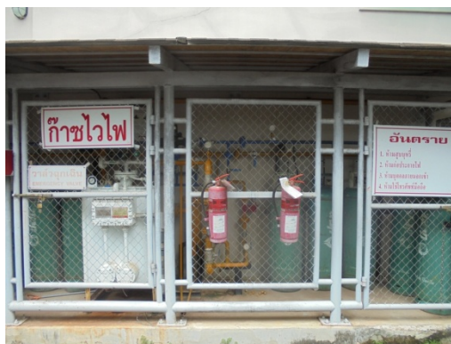
ภาพที่ 3-39 ถังเคมีดับเพลิง ติดตั้งไว้บริเวณที่เก็บถังแก๊ส
