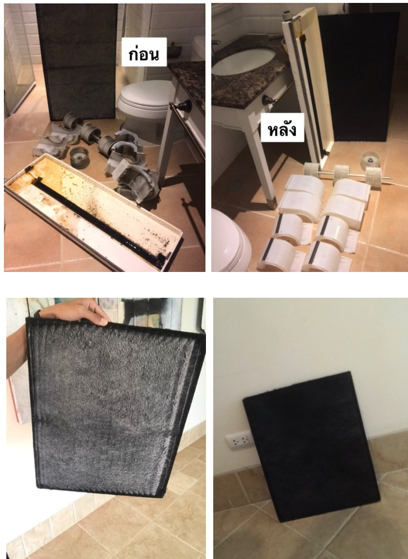
ภาพที่ 3-41 ล้างทำความสะอาดเครื่องปรับอากาศ
