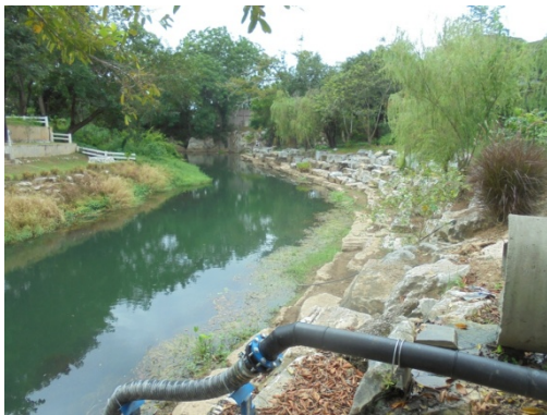
ภาพที่ 3-2 กำแพงดินเป็นภูเขารวมชาติ ใช้หินอ่อนตัดก้อน ทำเป็นกำแพงดินมีความลาดเอียงไม่เกิน 45 องศา และบ่อพักน้ำก่อนระบายออก
