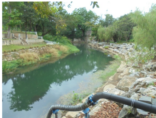
ภาพที่ 3-2 กำแพงดินเป็นภูเขารวมชาติ ใช้หินอ่อนตัดก้อน ทำเป็นกำแพงดินมีความลาดเอียงไม่เกิน 45 องศา และบ่อพักน้ำก่อนระบายออก
