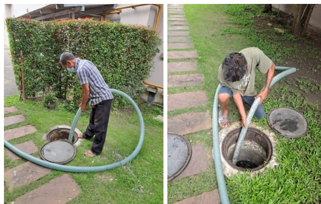
ภาพที่ 3-10 สูบตะกอนออกจากถังแยกตะกอน
