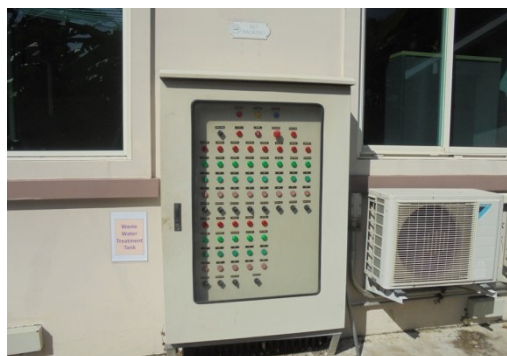
ภาพที่ 3-11 แยกมิเตอร์แผงควบคุมระบบบ่อบำบัดน้ำเสียโดยเฉพาะ
