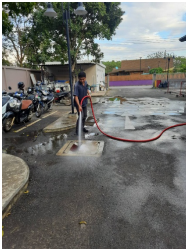
ภาพที่ 3-45 ล้างทำความสะอาดท่อระบายน้ำ ให้การระบายน้ำดี ไม่มีขยะอุดตัน
