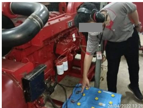
ภาพที่ 3-48 ช่างอาคารทดสอบเครื่องสูบน้ำดับเพลิง
