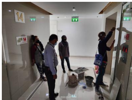
ภาพที่ 3-42 ซ่อมแซมกระเบื้องที่แตกชำรุดด้านหน้าลิฟต์
