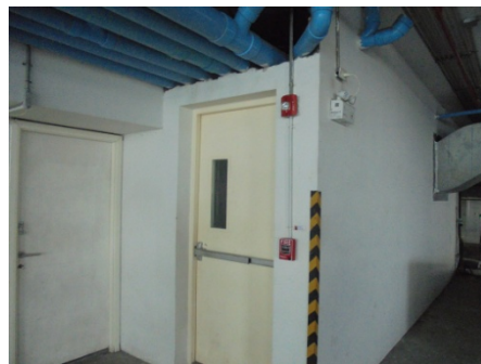
ภาพที่ 3-33 ระบบหัวกระจายน้ำอัตโนมัติ ประตูทางออกฉุกเฉิน
