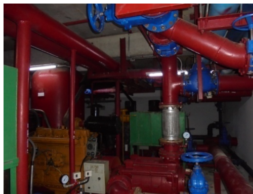
ภาพที่ 3-17 ห้องปั้มน้ำและปั้มน้ำดับเพลิง
