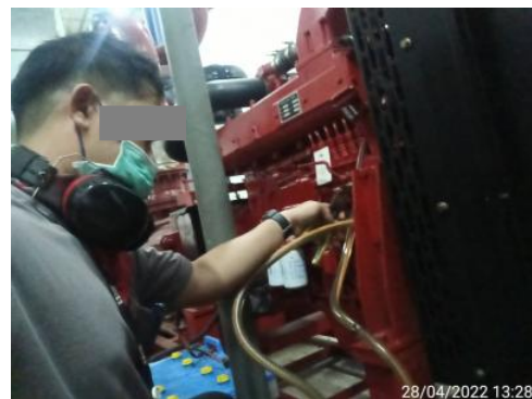
ภาพที่ 3-48 ช่างอาคารทดสอบเครื่องสูบน้ำดับเพลิง
