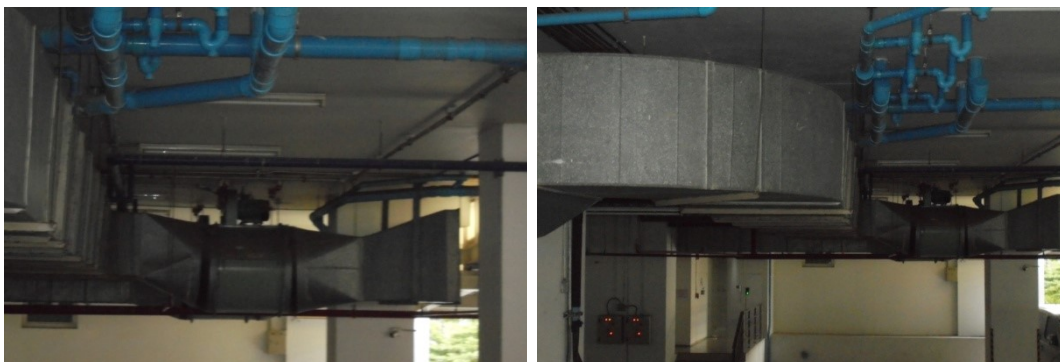
ภาพที่ 3-6 ช่องเปิดระบายอากาศที่ชั้นจอดรถ และพัดลมกรองอากาศติดตั้งไว้ที่ชั้น 4 ของอาคารจอดรถ
