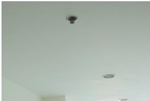
ภาพที่ 3-33 ระบบหัวกระจายน้ำอัตโนมัติ ประตูทางออกฉุกเฉิน
