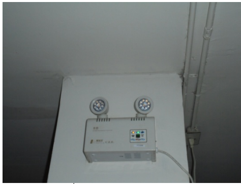
ภาพที่ 3-32 ไฟฟ้าส่องสว่างฉุกเฉิน
