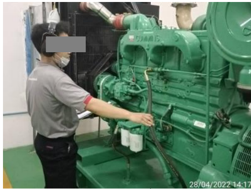
ภาพที่ 3-47 ช่างอาคารทดสอบเครื่องยนต์กำเนิดไฟฟ้าสำรอง
