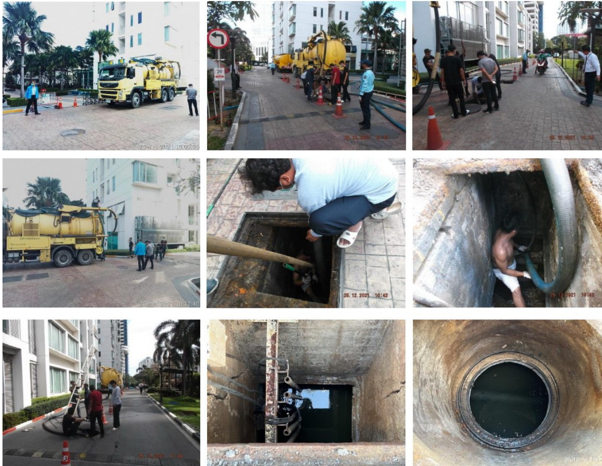
ภาพที่ 3-38 การสูบล้างปฏิภูมในบ่อเกรอะ
