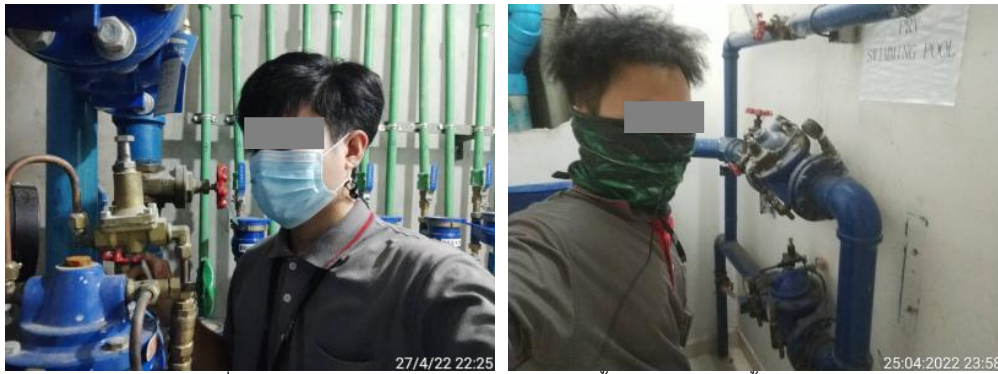
ภาพที่ 3-51 ช่างอาคารตรวจสอบวาล์วลดแรงดันน้ำ ระบบการจ่ายน้ำประปา
