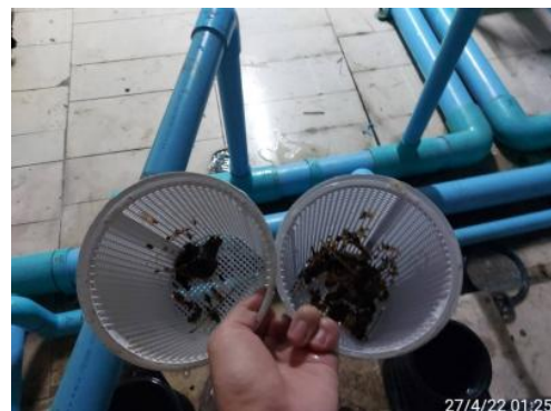
ภาพที่ 3-50 ทำความสะอาด ซัด และดูดตะกอนสวะร้ายน้ำ
