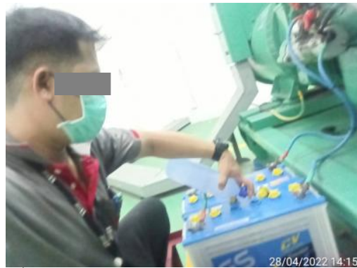
ภาพที่ 3-47 ช่างอาคารทดสอบเครื่องยนต์กำเนิดไฟฟ้าสำรอง
