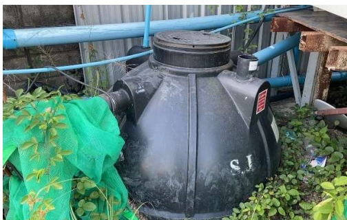
รูปที่ 18 ระบบบำบัดน้ำเสีย
