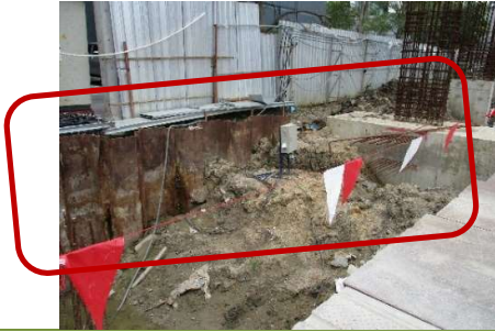
รูปที่ 8 ผนังกันดิน (Sheet Pile)
