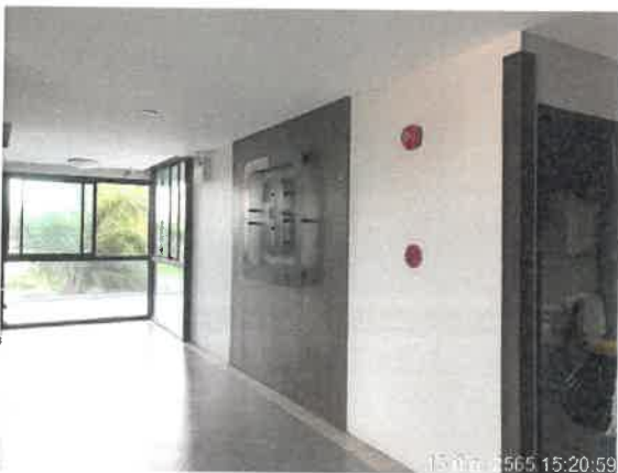
รูปที่ 2-35 แสดงกริ่งสัญญาณเตือนภัย (Alarm Bell) และเครื่องแจ้งเหตุโดยใช่มือกด (Fire Manual Station Unit) ภายในอาคาร
