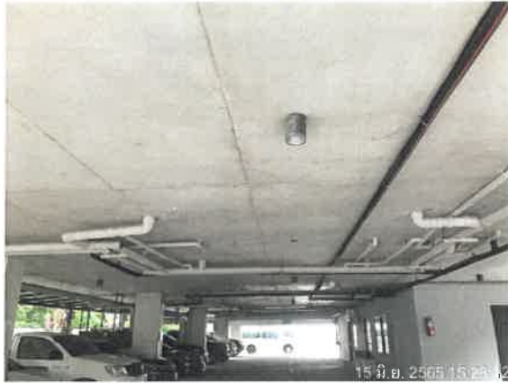
รูปที่ 2-21 แสดงการติดตั้งโคมไฟดาวนไลท์ภายในโครงการ
