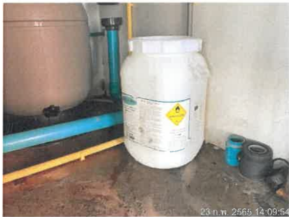
รูปที่ 2-47 แสดงสารคลอรีนที่บรรจุในภาชนะที่ปิดมิดชิด พร้อมมีฉลากระบุชื่อสารเคมี และไฟฟาส่องสว่างภายในห้องเก็บสารเคมี
