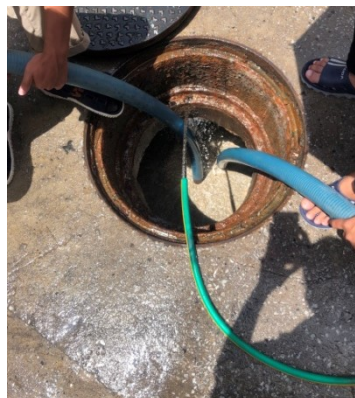
ภาพที่ 3-8 การสูบน้ำจากบ่อบำบัดน้ำเสีย
