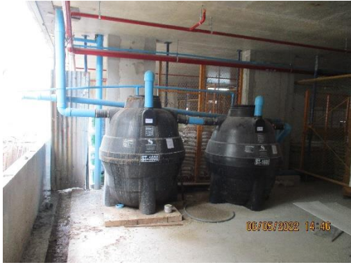
รูปที่ 19 ถังบำบัดน้ำเสียสำเร็จรูป
