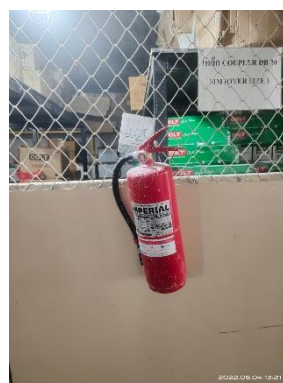
รูปที่ 30 ถังดับเพลิง ป้ายแนะนำการใช้งาน และป้ายตรวจสอบสภาพการใช้งาน
