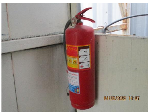
รูปที่ 30 ถังดับเพลิง ป้ายแนะนำการใช้งาน และป้ายตรวจสอบสภาพการใช้งาน
