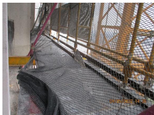
รูปที่ 48 ตะแกรงป้องกันวัสดุตกหล่น
