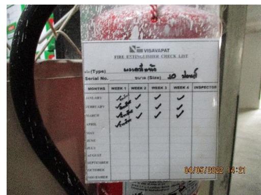
รูปที่ 6 ตรวจสอบสภาพพร้อมใช้งานของถังดับเพลิง
