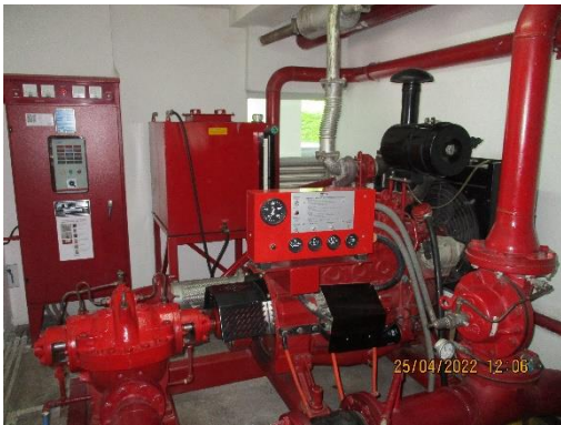
รูปที่ 11 เครื่องสูบน้ำดับเพลิง
