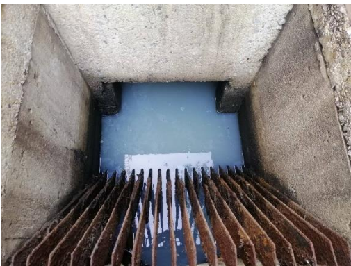
รูปที่ 31 ตะแกรงดักขยะ
