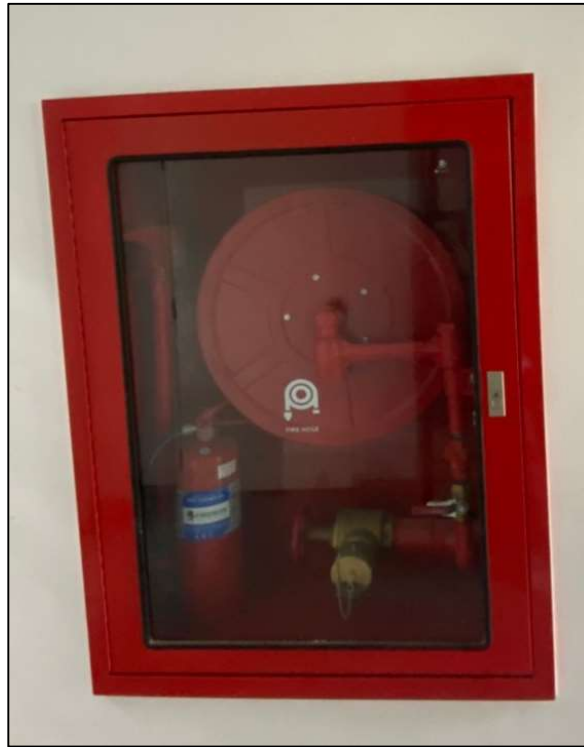
ภาพที่ 19 แสดงตู้เก็บสายน้ำดับเพลิง-ถังดับเพลิง
