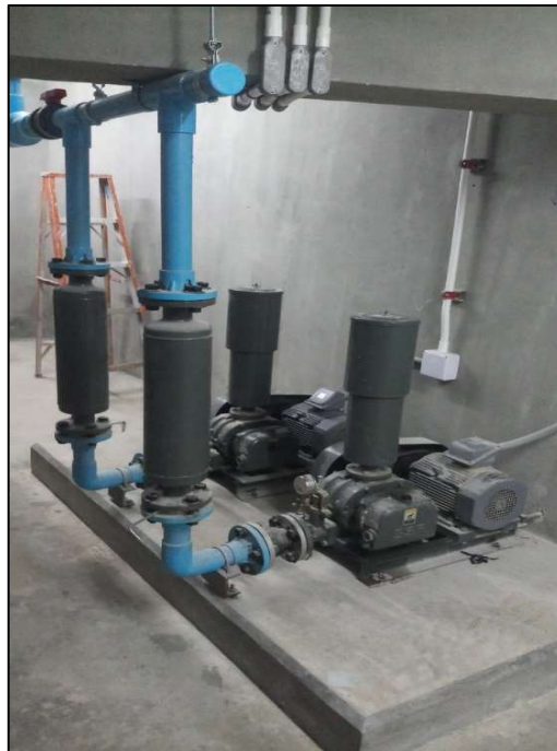
ภาพที่ 38 แสดงปั๊มสำหรับเติมอากาศบ่อบำบัดน้ำเสีย
