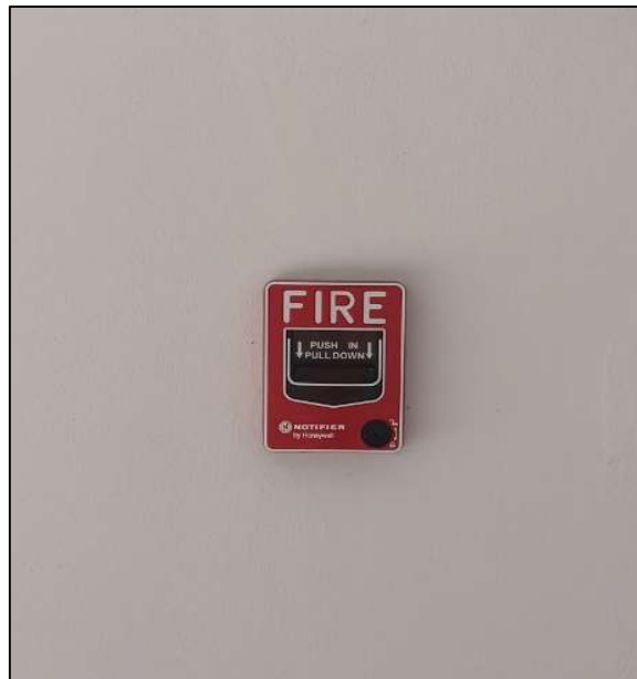
ภาพที่ 20 แสดงอุปกรณ์แจ้งเหตุเพลิงไหม้ (FIRE)
