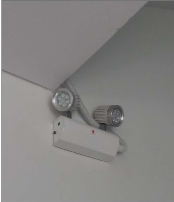
ภาพที่ 23 แสดงไฟส่องสว่างฉุกเฉิน
