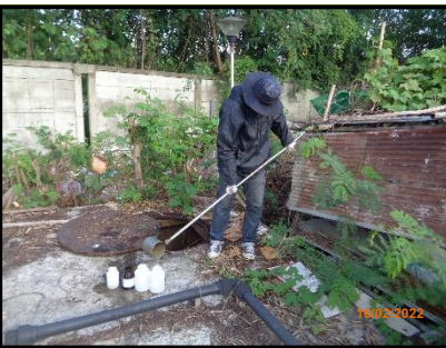
บ่อกักหลังผ่านระบบบำบัดน้ำเสีย ชุดที่ 3
