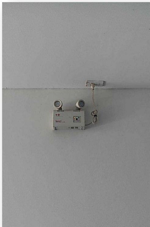
ภาพที่ 31 แสดงไฟส่องสว่างฉุกเฉิน
