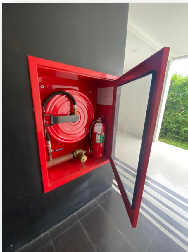
ภาพที่ 32 แสดงตู้เก็บสายน้ำดับเพลิง-ถังดับเพลิงแสดงถังดับเพลิง
