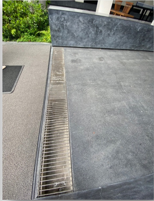
ภาพที่ 17 และ 18 แสดงตะแกรงดักมูลฝอย
