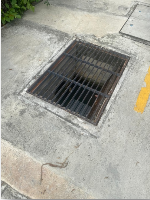
ภาพที่ 17 และ 18 แสดงตะแกรงดักมูลฝอย
