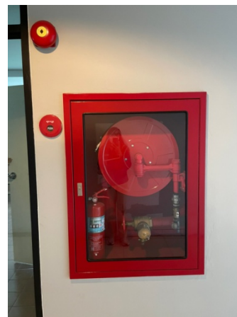
ตู้เก็บสายฉีดน้ำดับเพลิงพร้อมอุปกรณ์ (FHC)
