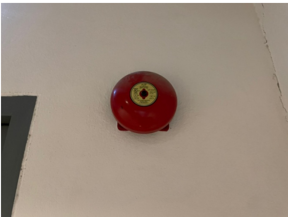
สัญญาณแจ้งเตือนแบบกริ่ง (Alarm Bell)
