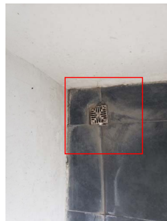
รูปที่ 2-21 ท่อรวบรวมน้ำจากการล้างห้องพักมูลฝอย
