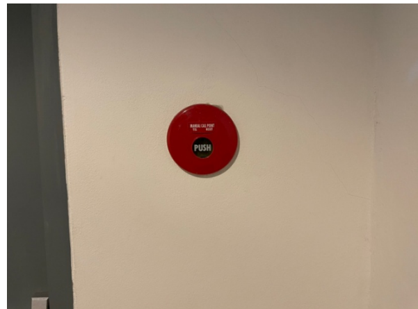
อุปกรณ์แจ้งเหตุแบบใช้มือ (Manual Station)
