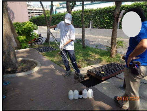
บ่อตรวจคุณภาพน้ำหลังผ่านระบบบำบัดน้ำเสีย
