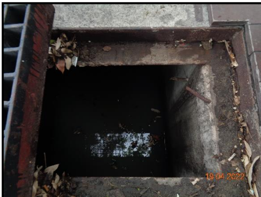
บ่อตรวจคุณภาพน้ำหลังผ่านระบบบำบัดน้ำเสีย
