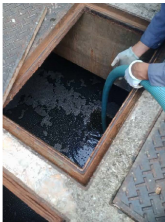
ภาพที่ 4-9 ระบบบำบัดน้ำเสีย บำรุงรักษาระบบบำบัดน้ำเสียและสูบน้ำจากบ่อเก็บตะกอน
