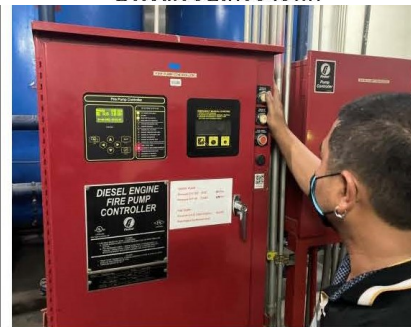
ภาพขณะตรวจเช็ค FIRE PUMP CONTROLLER
