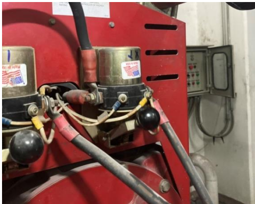
ภาพขณะตรวจเช็คทำความสะอาด บริเวณรอบเครื่องยนต์
