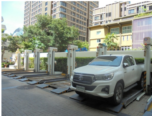
ภาพที่ 4-7 ที่จอดรถแบบ 2 Layer Lifting-Sliding Type ติดตั้งไว้ที่ทิศตะวันตกและทิศตะวันออกของโครงการอยู่ระหว่างซ่อมแซม
