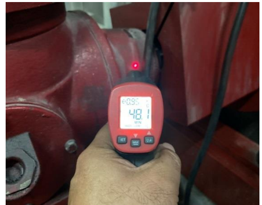
ภาพขณะตรวจวัดอุณหภูมิปั๊มขณะทำงาน
