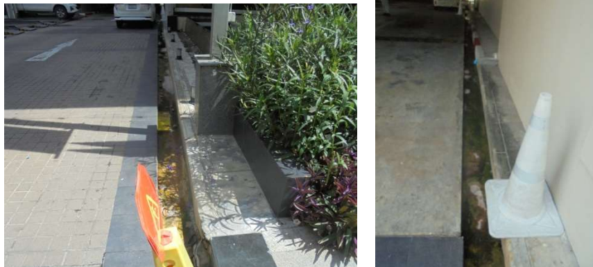
ภาพที่ 4-23 ลอกท่อระบายน้ำ มีตะแกรงดักขยะ ปัจจุบันสามารถระบายน้ำได้เป็นอย่างดี
