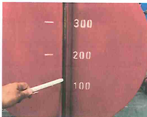
ภาพขณะตรวจเช็คระดับน้ำมันในถังโซล่า
