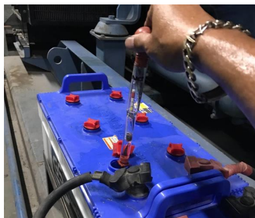
ขณะทำการตรวจเช็คสภาพแบตเตอรี่
