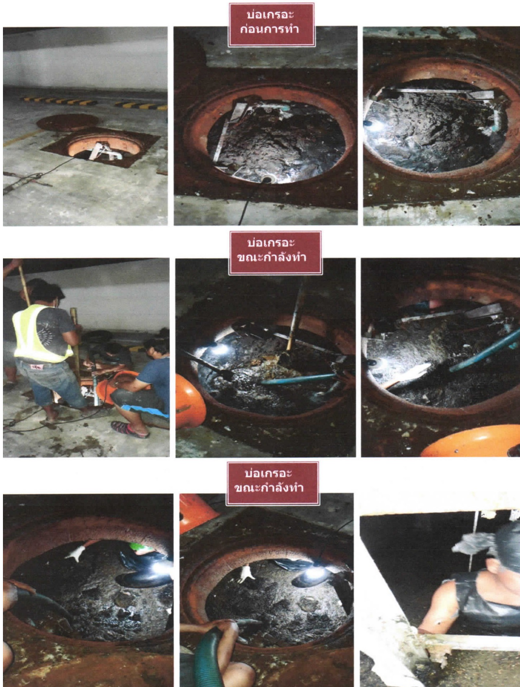
ภาพที่ 4-26 ดูตะกอนจากบ่อเกรอะ
