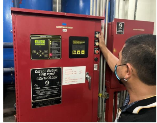
ภาพขณะตรวจเช็คตู้ FIRE PUMP CONTROLLER
