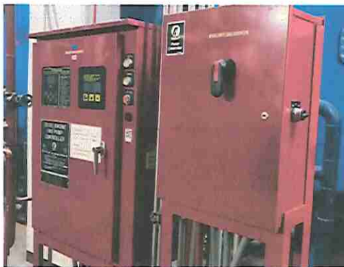
ภาพขณะตรวจเช็คตู้ CONTROL FIRE PUMP และตู้ CONTROL JOCKEY PUMP
