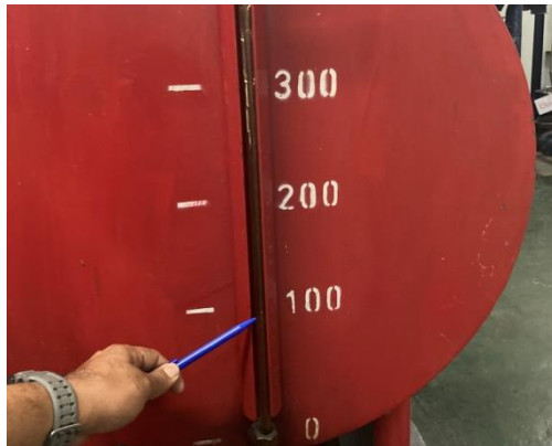
ภาพขณะตรวจเช็คระดับน้ำมันในถังโซล่า
