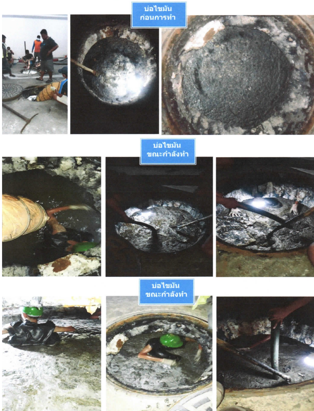
ภาพที่ 4-27 ดูตะกอนไขมันในบ่อดักไขมัน
