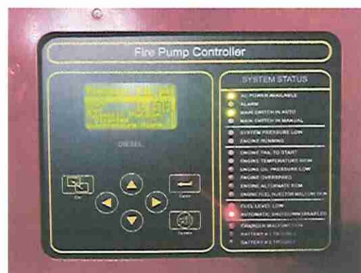
ภาพขณะติดเครื่องยนต์ทดสอบการทำงาน
