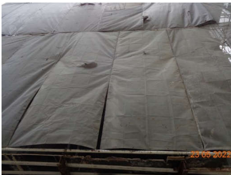
ภาพที่ 2.2-18 ผ้าใบกันฝุ่น (Mesh Sheet)
