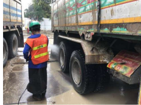
ภาพที่ 2.2-8 พื้นที่ล้างล้อรถบรรทุก
