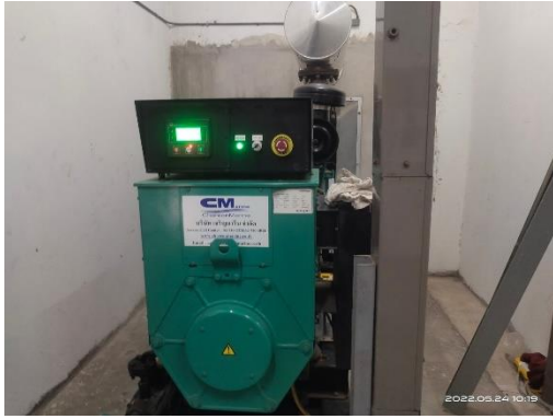
รูปที่ 17 เครื่องกำเนิดไฟฟ้าสำรอง
