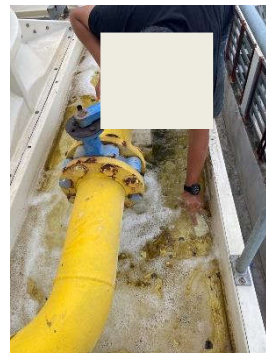
ภาพที่ 2.2-39 การทำความสะอาด และกำจัดตะกอนในท่อฝังเย็น
