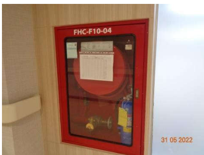
ภาพที่ 2.2-32 ตู้เก็บสายฉีดน้ำดับเพลิง พร้อมอุปกรณ์ (Fire Hose Cabinet : FHC)
