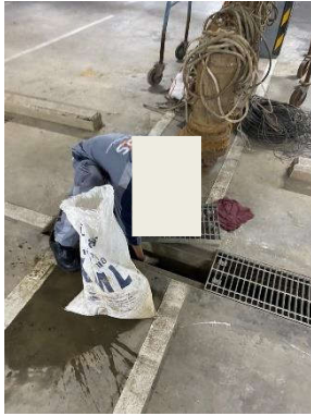
ภาพที่ 2.2-21 การขุดลอกท่อระบายน้ำ
