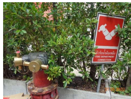
ภาพที่ 2.2-31 หัวรับน้ำดับเพลิง (Fire Department Connector : FDC)
