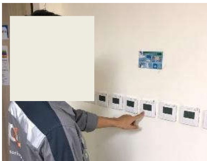
ภาพที่ 2.2-28 แยกสวิตช์ควบคุมอุปกรณ์ ไฟฟ้าแสงสว่าง
