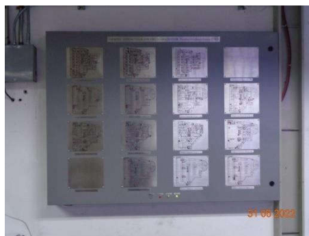
ภาพที่ 2.2-35 แผงควบคุม (Fire Alarm Control Panel : FCP)
