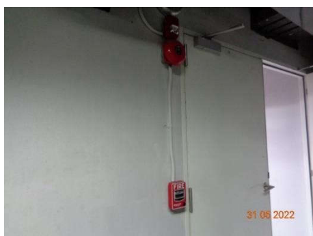
ภาพที่ 2.2-36 เครื่องแจ้งเหตุโดยใช่มือดึง (Fire Alarm Manual Station) และกริ่งสัญญาณเตือนภัย (Alarm Bell)
