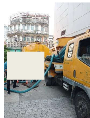
ภาพที่ 2.2-14 การสูบน้ำจากตะกอน จากระบบบำบัดน้ำเสีย
