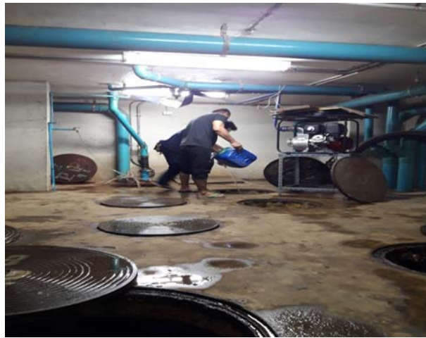
ภาพที่ 2.21 เจ้าหน้าที่ดูแลระบบบำบัดน้ำเสีย ทำความสะอาดถังไขมันและเติมจุลินทรีย์
