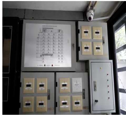
ภาพที่ 2.12 ตู้แสดงผลแจ้งเตือนกรณีเกิดเพลิงไหม้
