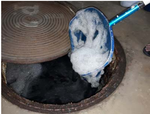
ภาพที่ 2.32 การตักไขมันจากบ่อบำบัดน้ำเสีย
