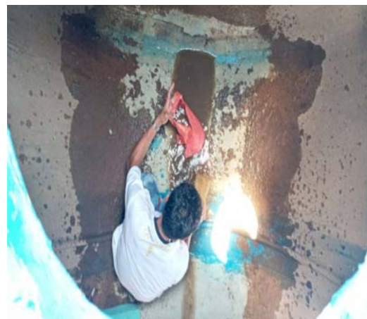
รูปที่ 2.40 ทำความสะอาดถังเก็บน้ำดี
