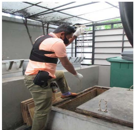
ภาพที่ 2.20 ป่อพักน้ำสุดท้าย และท่อระบายน้ำทิ้งจากระบบบำบัดน้ำเสีย โดยติดตะแกรงดักในท่อ เพื่อกรองตะกอนและไขมันก่อนระบายออกนอกโครงการ
