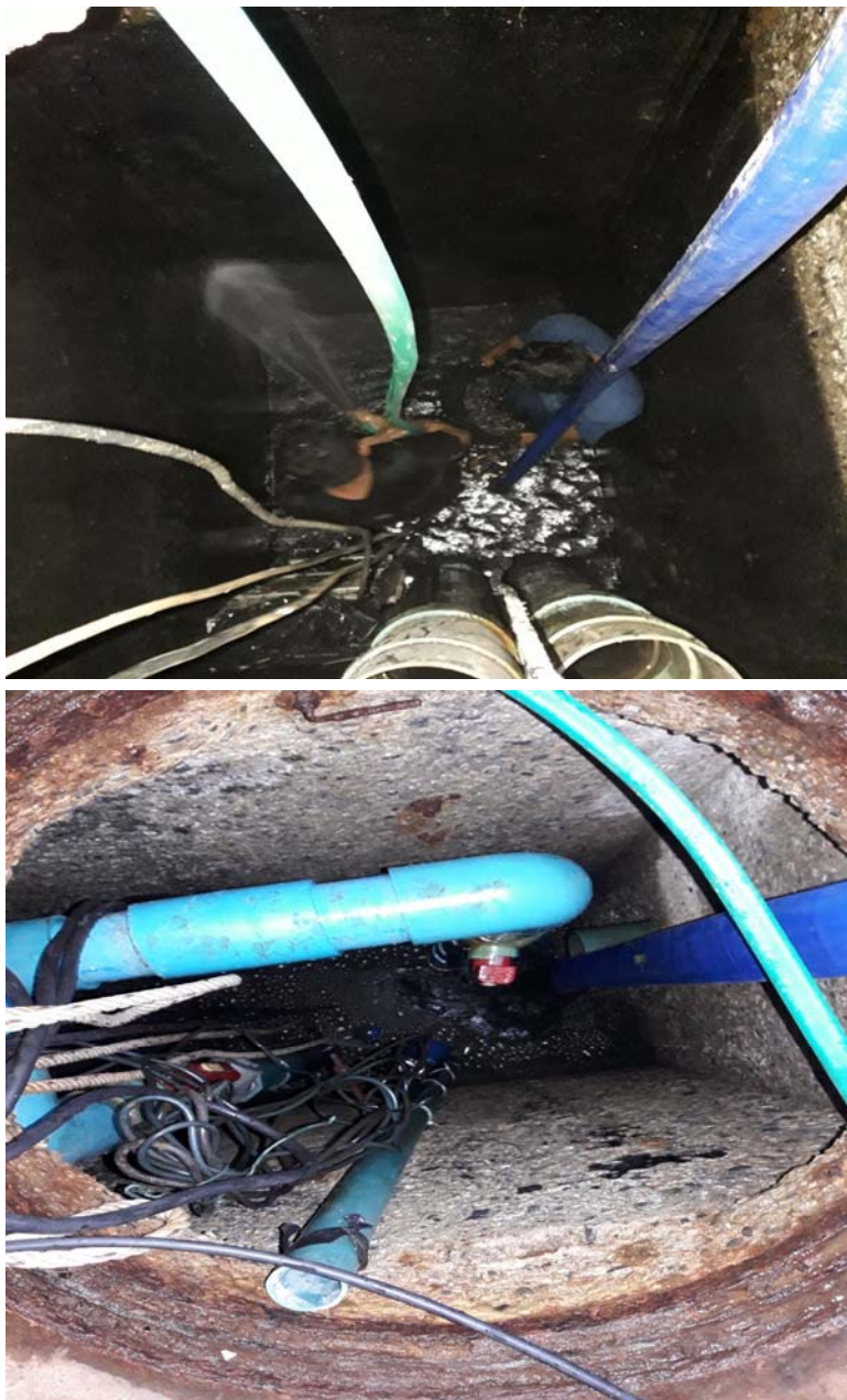
รูปที่ 2.41 ทำความสะอาดบ่อบำบัดน้ำเสียและสูบน้ำก่อน
