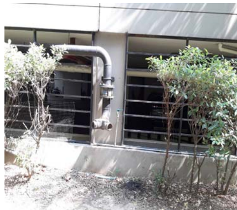
ภาพที่ 2.10 หัวรับน้ำดับเพลิงด้านหน้าอาคาร
