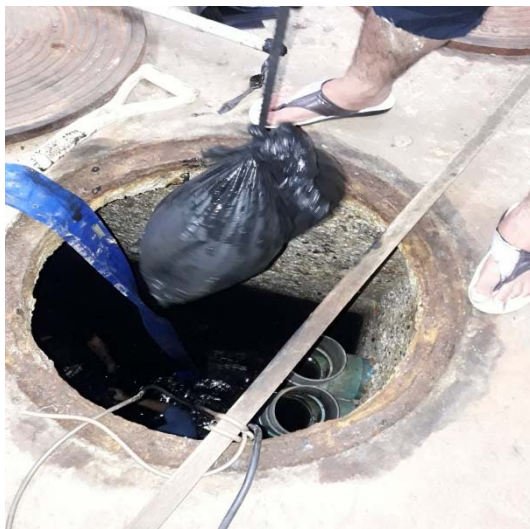
รูปการทำความสะอาดบ่อบำบัดน้ำเสีย
