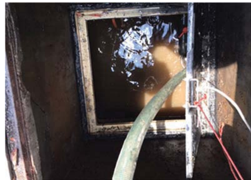
การสูบน้ำก่อนส่วนเกินระบบบำบัดน้ำเสีย
