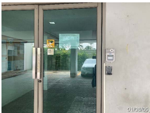
ระบบคีย์การ์ดควบคุมการเข้า-ออกโครงการและพื้นที่ส่วนกลาง
