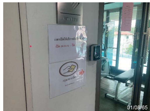
ระบบคีย์การ์ดควบคุมการเข้า-ออกโครงการและพื้นที่ส่วนกลาง
