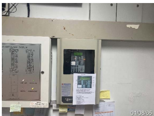
แผงควบคุมระบบสัญญาณแจ้งเหตุ
