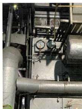
มาตรวัดความดันไอน้ำ หม้อไอน้ำ 60 ตัน/ชั่วโมง (3)
