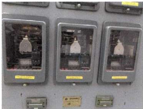
อุปกรณ์ป้องกันการรั่วไหลของแรงดันไฟฟ้า Gen 1
