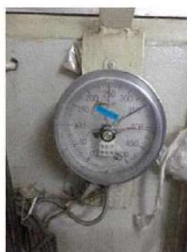
มาตรวัดอุณหภูมิ Gen.3
