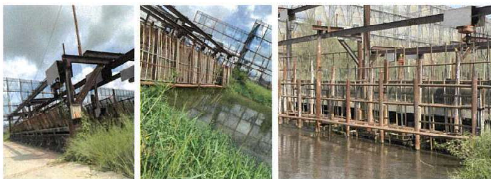
รูปที่ 3-23 ตะแกรงดักเศษกากอ้อยก่อนเข้าสู่ระบบบำบัดน้ำเสีย
