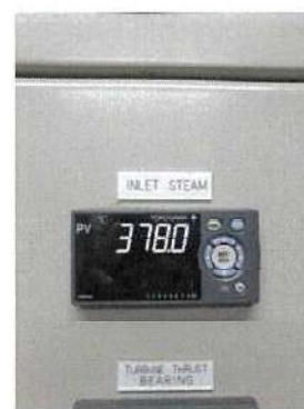
มาตรวัดอุณหภูมิ Gen.4
