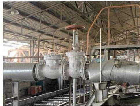
Check Valve หม้อไอน้ำ 60 ตัน/ชั่วโมง (2)
