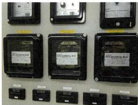
อุปกรณ์ป้องกันการรั่วไหลของแรงดันไฟฟ้า Gen 3
