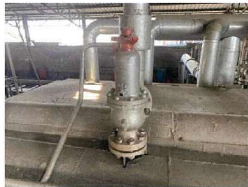
Safety Valve หม้อไอน้ำ 60 ตัน/ชั่วโมง(1)
