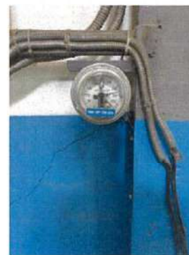
มาตรวัดอุณหภูมิ Gen.2
