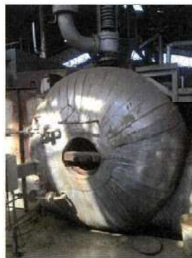
ฉนวนกันความร้อนหม้อไอน้ำ 200 ตัน/ชั่วโมง (A)
