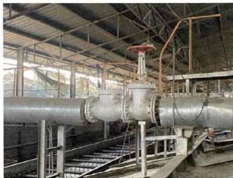
Check Valve หม้อไอน้ำ 60 ตัน/ชั่วโมง (3)
