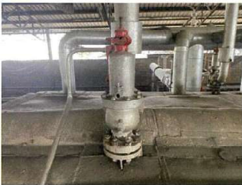
Safety Valve หม้อไอน้ำ 60 ตัน/ชั่วโมง(2)
