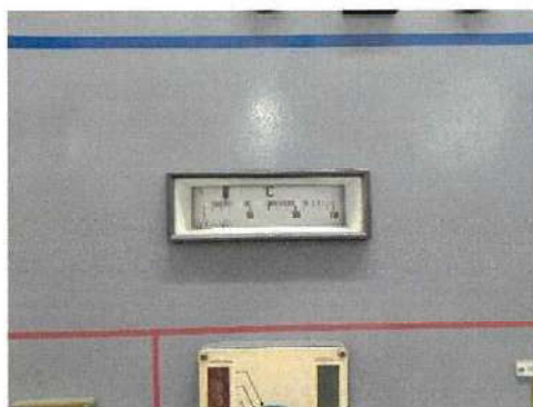
อุปกรณ์วัดอุณหภูมิขดลวดของเครื่องกำเนิดไฟฟ้า Gen 1
