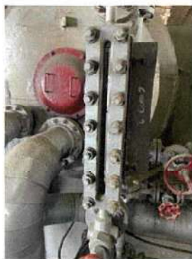
มาตรวัดระดับน้ำ หม้อไอน้ำ 60 ตัน/ชั่วโมง (1)
