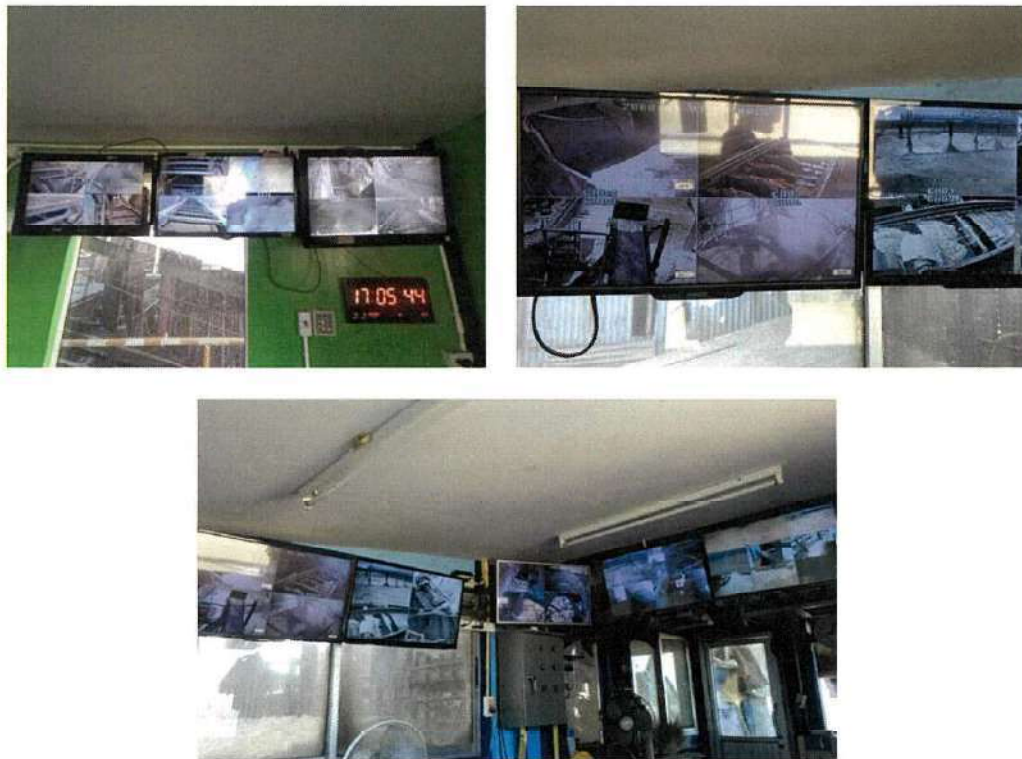
รูปที่ 3-55 จอมอนิเตอร์ ควบคุมการทำงานของระบบสายพานลำเลียงกากอ้อย
