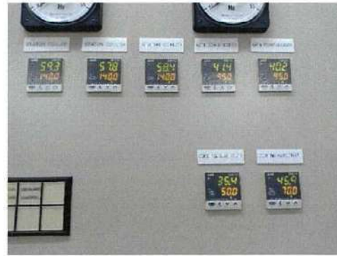
อุปกรณ์วัดอุณหภูมิขดลวดของเครื่องกำเนิดไฟฟ้า Gen 4
