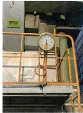
มาตรวัดความดันไอน้ำ หม้อไอน้ำ 200 ตัน/ชั่วโมง (B)
