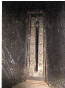
มาตรวัดระดับน้ำ หม้อไอน้ำ 40 ตัน/ชั่วโมง
