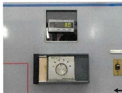
อุปกรณ์วัดอุณหภูมิขดลวดของเครื่องกำเนิดไฟฟ้า Gen 2
