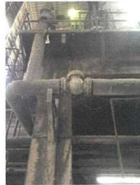
Check Valve หม้อไอน้ำ 80 ตัน/ชั่วโมง
