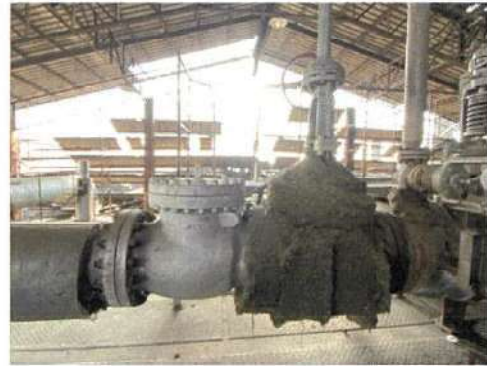
Check Valve หม้อไอน้ำ 200 ตัน/ชั่วโมง (B)
