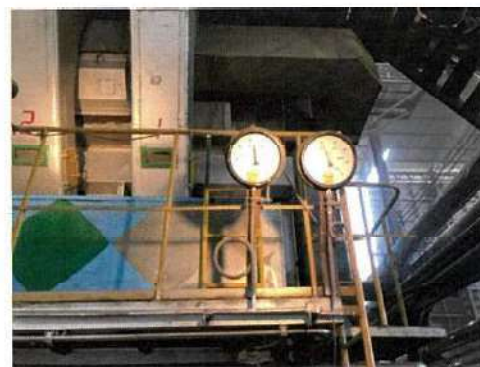
มาตรวัดความดันไอน้ำ หม้อไอน้ำ 200 ตัน/ชั่วโมง (A)
