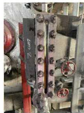
มาตรวัดระดับน้ำ หม้อไอน้ำ 60 ตัน/ชั่วโมง (2)
