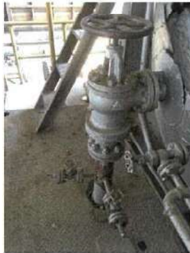
Check Valve หม้อไอน้ำ 40 ตัน/ชั่วโมง
