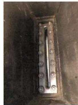
มาตรวัดระดับน้ำ หม้อไอน้ำ 80 ตัน/ชั่วโมง
