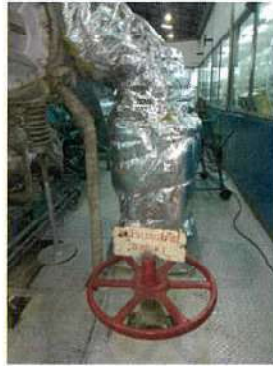
Pass valve Turbine GEN.1
