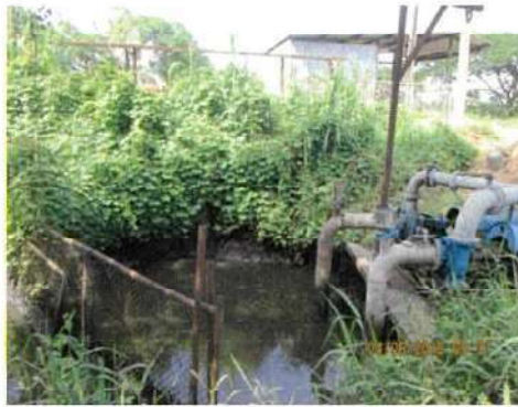
รูปที่ 3-26 บ่อแยกน้ำมัน (Oil Separator)
