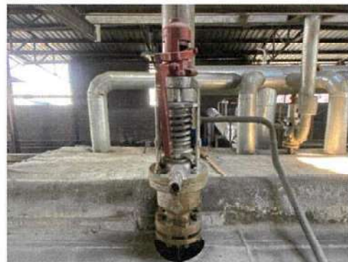
Safety Valve หม้อไอน้ำ 60 ตัน/ชั่วโมง(3)
