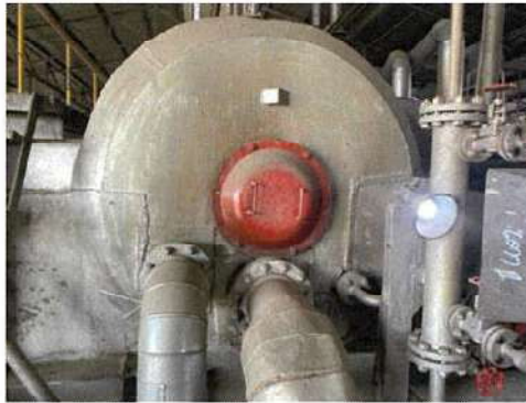
ฉนวนกันความร้อนของหม้อไอน้ำ 60 ตัน/ชั่วโมง (1)
