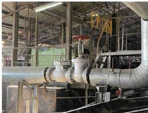
Check Valve หม้อไอน้ำ 60 ตัน/ชั่วโมง (1)
