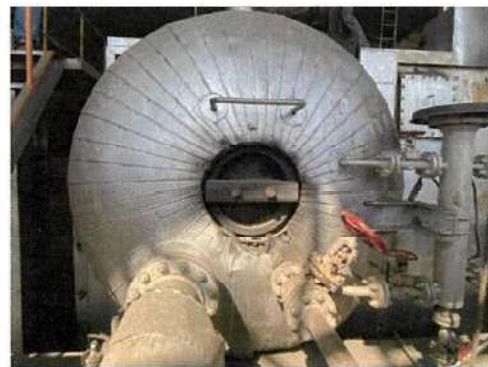
ฉนวนกันความร้อนหม้อไอน้ำ 200 ตัน/ชั่วโมง (B)
