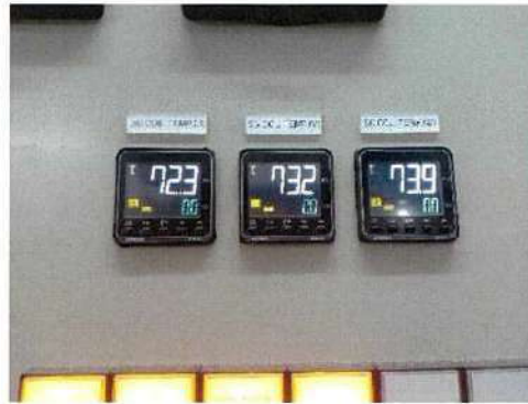
อุปกรณ์วัดอุณหภูมิขดลวดของเครื่องกำเนิดไฟฟ้า Gen 3
