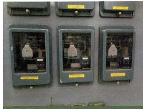
อุปกรณ์ป้องกันการรั่วไหลของแรงดันไฟฟ้า Gen 2
