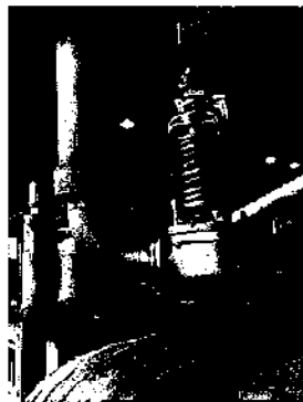
Safety Valve หม้อไอน้ำ 200 ตัน/ชั่วโมง (A)
