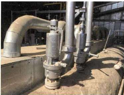
Safety Valve หม้อไอน้ำ 40 ตัน/ชั่วโมง
