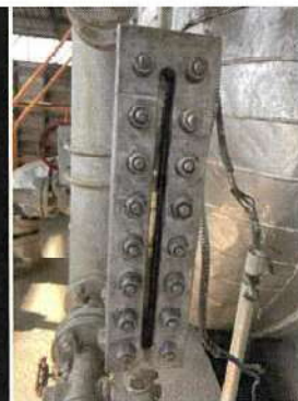
มาตรวัดระดับน้ำ หม้อไอน้ำ 200 ตัน/ชั่วโมง (B)
