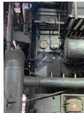
มาตรวัดความดันไอน้ำ หม้อไอน้ำ 60 ตัน/ชั่วโมง (2)
