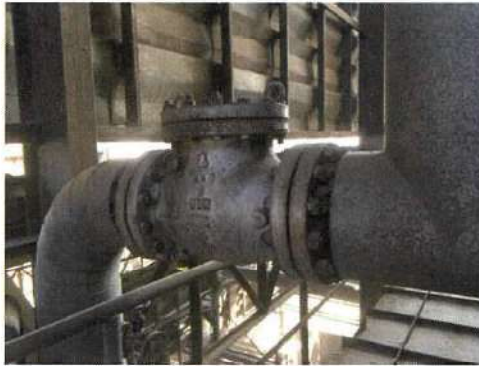
Check Valve หม้อไอน้ำ 200 ตัน/ชั่วโมง (A)
