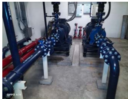
รูปที่ 2.1-12 ระบบสูบน้ำประปาในโครงการ
