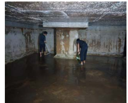
รูปที่ 2.1-13 การล้างถังเก็บน้ำโครงการ
