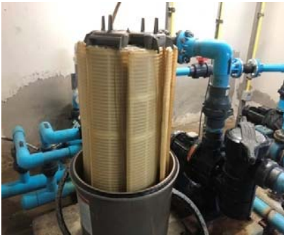
รูปที่ 2.1-14 ระบบกรองน้ำสระว่ายน้ำ (ระบบเกลือ)
