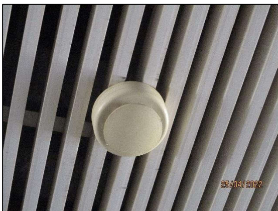
รูปที่ 2-47 อุปกรณ์ตรวจจับควัน
