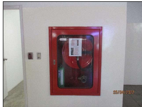
รูปที่ 2-38 ตู้เก็บอุปกรณ์ดับเพลิงภายในอาคาร
