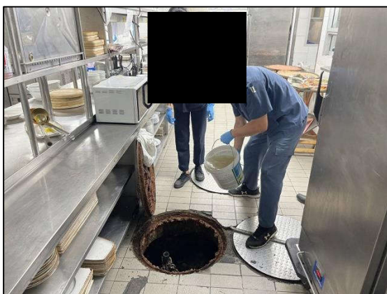
รูปที่ 2-25 การดูแลทำความสะอาดบ่อดักไขมัน
