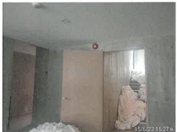
รูปที่ 2-32 แสดงกริ่งสัญญาณเตือนภัย และเครื่องแจ้งเหตุโดยใช้มือกด บริเวณด้านหน้าลิฟต์แต่ละชั้นของโครงการ
