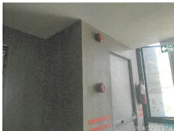
รูปที่ 2-32 แสดงกริ่งสัญญาณเตือนภัย และเครื่องแจ้งเหตุโดยใช้มือกด บริเวณด้านหน้าลิฟต์แต่ละชั้นของโครงการ
