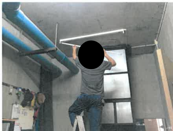
รูปที่ 2-22 แสดงเจ้าหน้าที่ทำความสะอาดหลอดไฟ และเปลี่ยนหลอดที่เสื่อมสภาพภายในโครงการ
