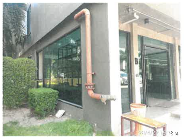
รูปที่ 2-33 แสดงติดตั้งหัวรับน้ำดับเพลิง FDC บริเวณด้านหน้าโครงการ
