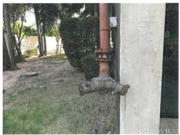
รูปที่ 2-33 แสดงติดตั้งหัวรับน้ำดับเพลิง FDC บริเวณด้านหน้าโครงการ
