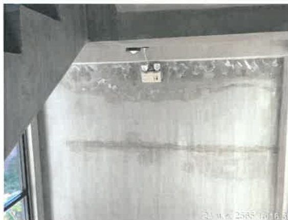
รูปที่ 2-31 แสดงระบบไฟส่องสว่างฉุกเฉิน (Emergency light) บริเวณบันไดหลัก และบริเวณทางเดินแต่ละชั้นของโครงการ
