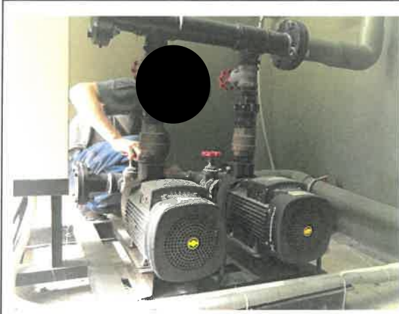
รูปที่ 2-10 แสดงการติดตั้งมอเตอร์ไฟฟ้าระบบบำบัดน้ำเสียของโครงการ
