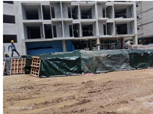
รูปที่ 10 การติดตั้งผ้าใบคลุมบริเวณอาคารที่มีการก่อสร้าง
