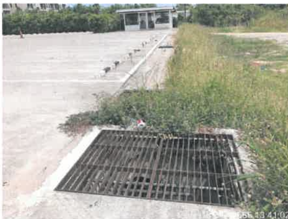
รูปที่ 2-22 แสดงบ่อพักน้ำ และตะแกรงดักมูลฝอยบริเวณจุดระบายน้ำออกจากท่อระบายน้ำของโครงการ
