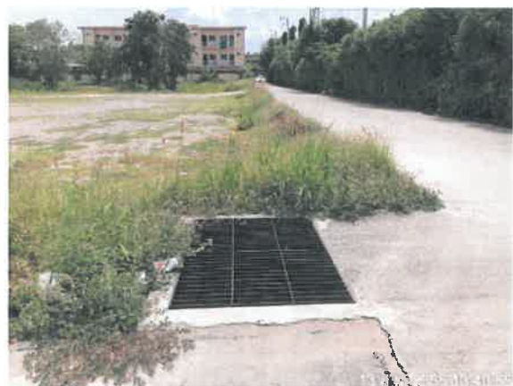
รูปที่ 2-22 แสดงบ่อพักน้ำ และตะแกรงดักมูลฝอยบริเวณจุดระบายน้ำออกจากท่อระบายน้ำของโครงการ
