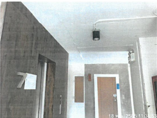
รูปที่ 2-18 แสดงการติดตั้งโคมไฟดาวนไลท์ บริเวณทางเดินภายในอาคาร หน้าห้องพัก และบริเวณด้านหลังห้องพัก
