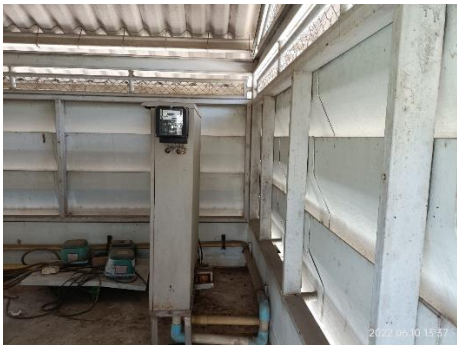
รูปที่ 2-13 การติดตั้งมอเตอร์ไฟฟ้าของระบบบำบัดน้ำเสียและการควบคุมการทำงานของระบบบำบัดน้ำเสีย
