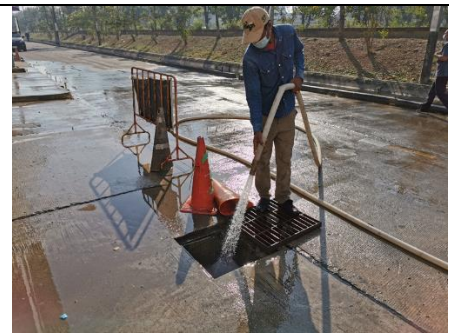
รูปที่ 2-12 ภาพการตรวจสอบระบบท่อระบายน้ำภายในพื้นที่โครงการ
