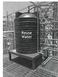
Tank เก็บน้ำ Blow down และถาดคืนเพื่อเพื่อนำกลับมาใช้ใหม่ในกระบวนการ
