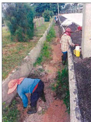
ภาพที่ 2-10 การทำความสะอาดและลอกตะกอนในรางระบายน้ำฝนในพื้นที่นิคมฯ
