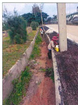
ภาพที่ 2-10 การทำความสะอาดและลอกตะกอนในรางระบายน้ำฝนในพื้นที่นิคมฯ
