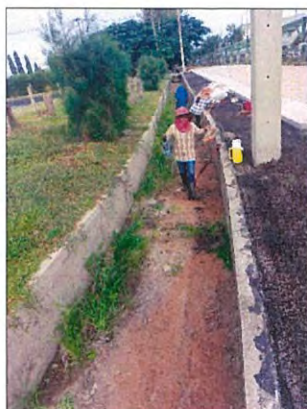
ภาพที่ 2-10 การทำความสะอาดและลอกตะกอนในรางระบายน้ำฝนในพื้นที่นิคมฯ
