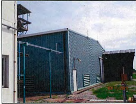
ภาพที่ 2-6 ตัวอย่างการติดตั้งอุปกรณ์ที่ทำให้เกิดเสียงดังในห้องปิดของนิคมของโรงงานภายในอุตสาหกรรมเอเชีย
