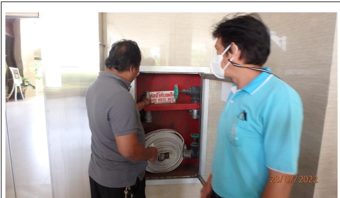
รูปที่ 2-6 การสุ่มตรวจสอบความพร้อมของตู้สายฉีดน้ำดับเพลิง
