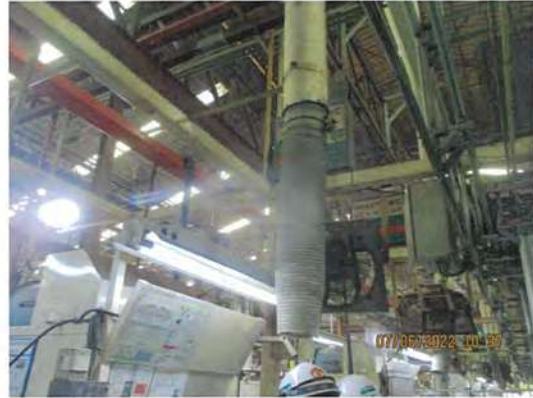
รูปที่ 23 การติดตั้งระบบจ่ายลมเย็นเฉพาะจุด
