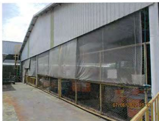
รูปที่ 11 กันสาดผ้าใบบริเวณอาคารกักเก็บขยะและกากของเสีย
