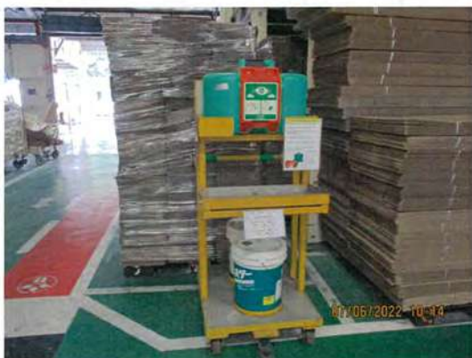
รูปที่ 32 อ่างล้างตาฉุกเฉิน
