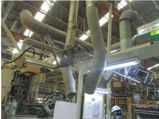
รูปที่ 23 การติดตั้งระบบจ่ายลมเย็นเฉพาะจุด
