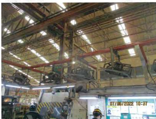
รูปที่ 22 การติดตั้งพัดลมระบายอากาศ
