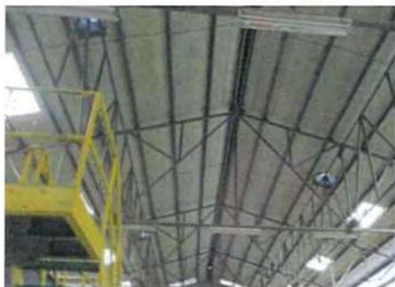
รูปที่ 27 การติดตั้งฉนวนกันความร้อนใต้หลังคา
