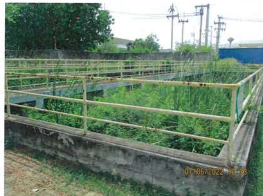
รูปที่ 8 บ่อพักน้ำเสียหลังผ่านการบำบัด
