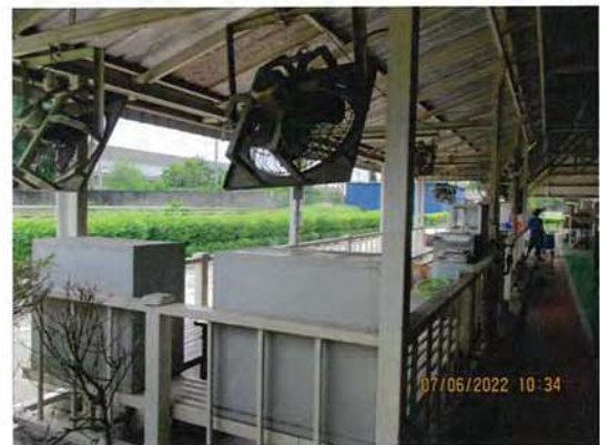
รูปที่ 22 การติดตั้งพัดลมระบายอากาศ
