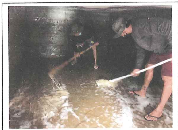
ขัดล้างด้วยแปรงผสมน้ำยาขัดล้าง
