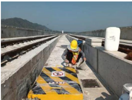
งาน Install Door of Deck Opening for Service
