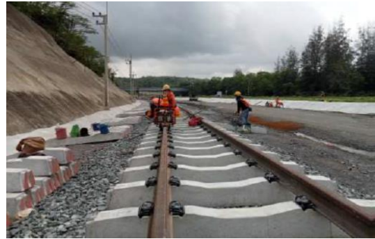
งาน Fastening for Monoblock Concrete Sleepers
