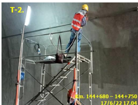
งานเดินท่อระบบแสงสว่างในอุโมงค์
