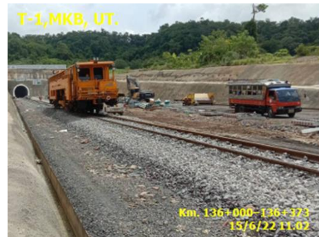
งาน Spread Ballast and Tamp to First Level
