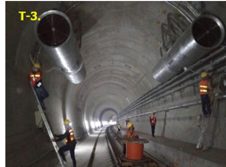
งานร้อยสายระบบไฟฟ้าและสื่อสาร
