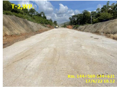
งาน Sub Ballast for Railway
