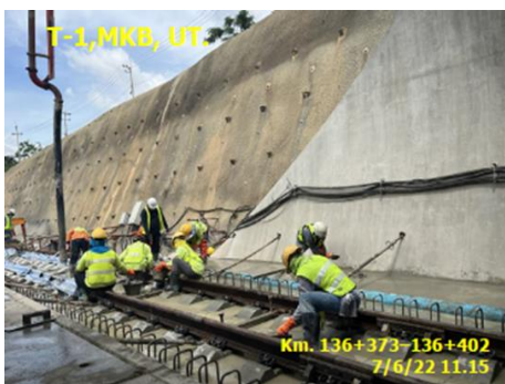
งาน Reinforced Concrete Track Bed
