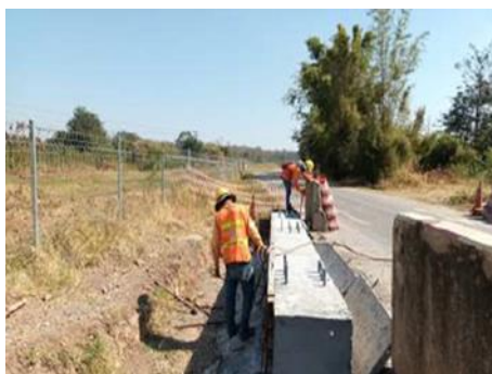
งานติดตั้งคานจำกัดความสูง (Height Restriction Barrier) ถนนบริการชุมชน (Service Road) ลอดใต้ทางรถไฟยกระดับ Pier 72 - Pier 73
