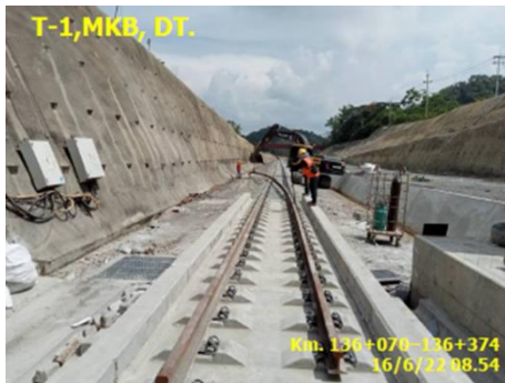
งาน Lay Plain Welded Track
