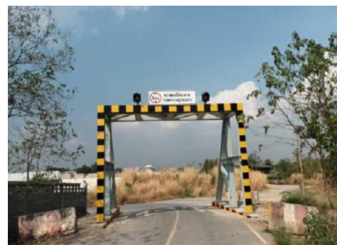
งานติดตั้งคานจำกัดความสูง (Height Restriction Barrier) ถนนบริการชุมชน (Service Road) ลอดใต้ทางรถไฟยกระดับ Pier 72 - Pier 73
