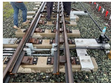
งาน Mockup of Point Machine Installation
