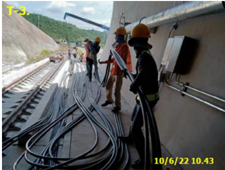
งานร้อยสายไฟฟ้าแรงสูงใน Duct bank
