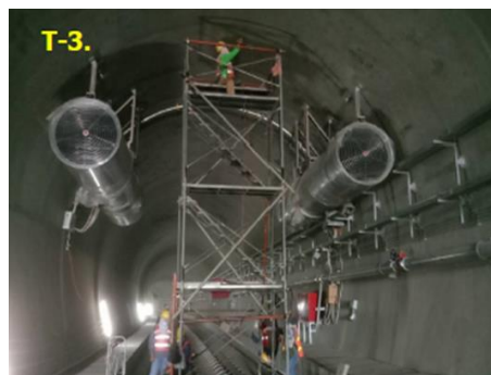
งานติดตั้งสาย Fiber Optic ตรวจจับความร้อน
