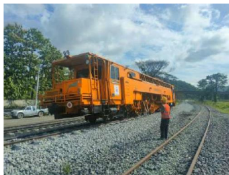
งาน Spread Ballast and Tamp to First Level
