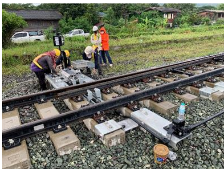
งาน Mockup of Point Machine Installation
