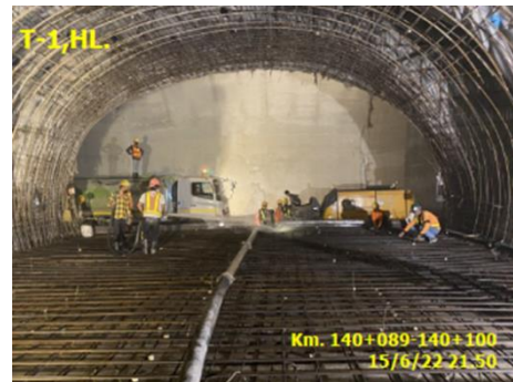
งาน Invert concrete for Equipment room
