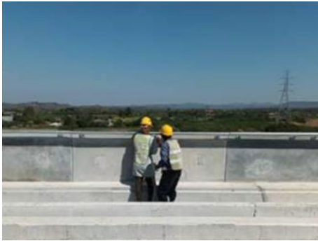
งานติดตั้ง Handrail
