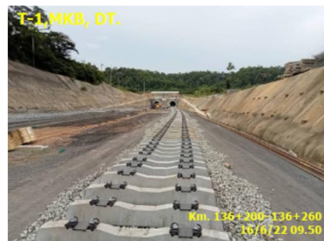
งาน Fastening System for Monoblock Concrete Sleeper
