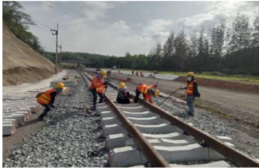
งานติดตั้ง Monoblock Concrete Sleepers
