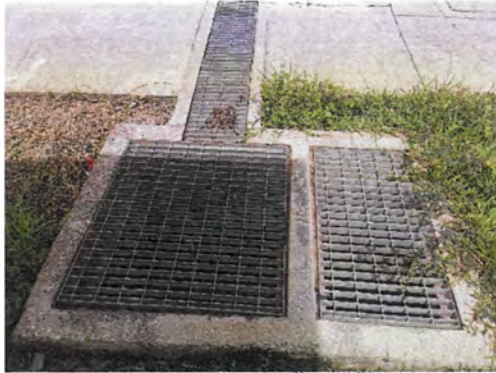
ภาพที่ 2-18 บ่อแยกน้ำและน้ำมัน
