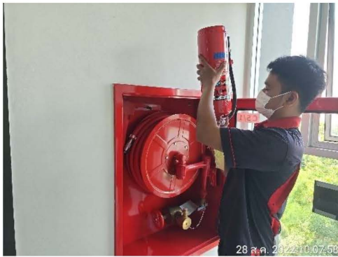
ภาพที่ 3-7 ตรวจสอบเครื่องดับเพลิงแบบหิ้ว
