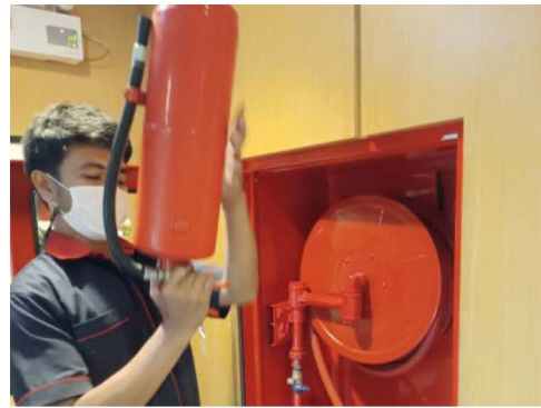
ภาพที่ 3-7 ตรวจสอบเครื่องดับเพลิงแบบหิ้ว
