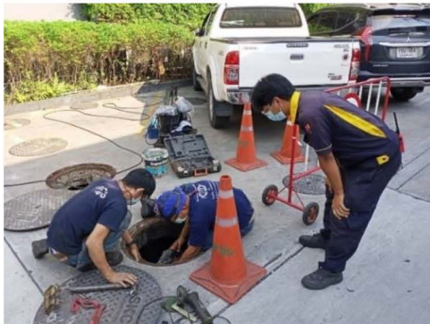
ภาพที่ 3-13 การตั้งกรวยจราจรให้ระวางบริเวณที่ปรับปรุง/ซ่อมแซม
