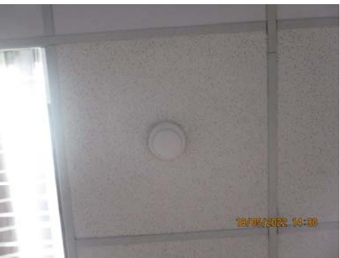
รูปที่ 3.2-36 เครื่องตรวจจับความร้อน (Heat Detector)
