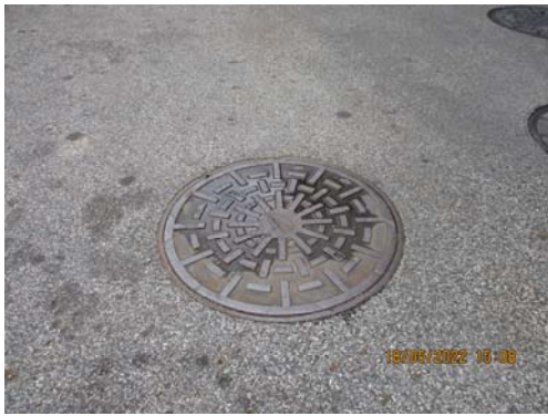
รูปที่ 3.2-7 บ่อรวบรวมน้ำเสียส่วนอาคารโรงแรม
