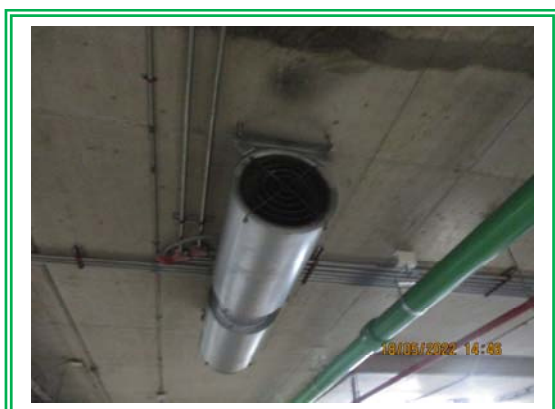
รูปที่ 3.2-57 ระบบระบายอากาศเพื่อลดมลพิษจากรถยนต์ บริเวณลานจอดรถชั้นใต้ดิน
