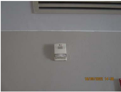
รูปที่ 3.2-34 กริ่งสัญญาณแจ้งเหตุ (Fire Alarm Bell)
