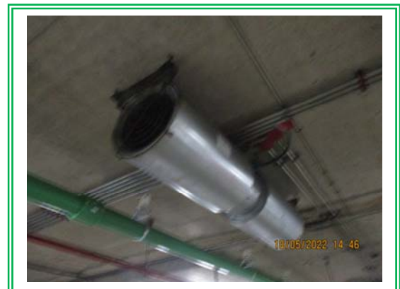
รูปที่ 3.2-57 ระบบระบายอากาศเพื่อลดมลพิษจากรถยนต์ บริเวณลานจอดรถชั้นใต้ดิน
