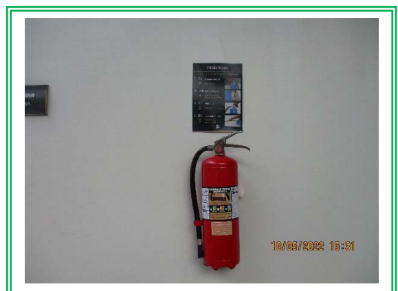
เครื่องดับเพลิงชนิดมือถือ (Fire Extinguisher)
