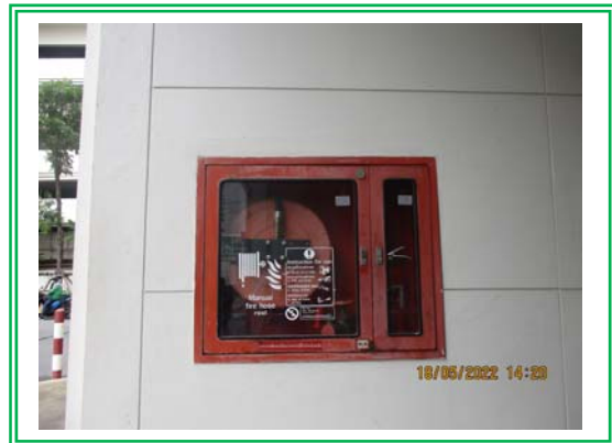
รูปที่ 3.2-30 ตู้เก็บสายดับเพลิง (Fire Host Cabinet)
