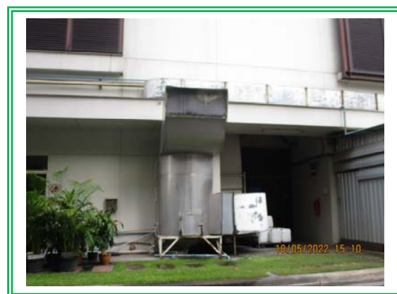
รูปที่ 3.2-48 Wet Scrubber สำหรับดักฝุ่นใยผ้าจากการซักรีดของโรงแรม
