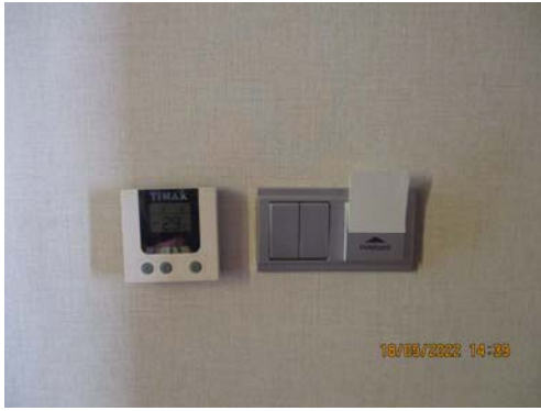
รูปที่ 3.2-49 ระบบ Key Tag ในห้องพัก ส่วนอาคารโรงแรม
