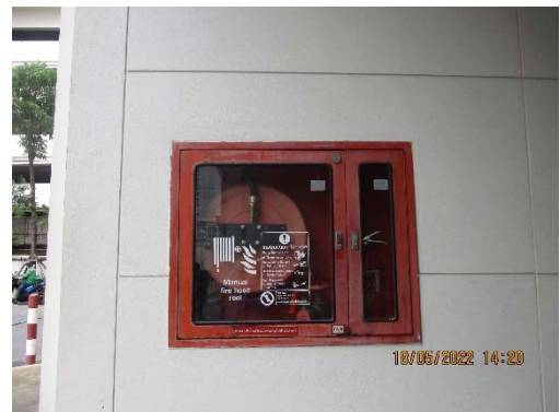
ตู้เก็บสายดับเพลิง (Fire Host Cabinet)
