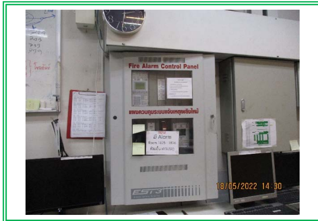
แผงควบคุมรวม (Fire Alarm Control Panel;FACP)
