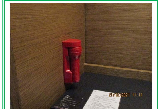
ไฟฉายภายในห้องพักกรณีเกิดเหตุฉุกเฉินไฟดับ
