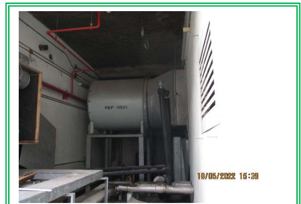
พัดลมดูดอากาศสำหรับบันไดหนีไฟของอาคาร
