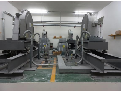
รูปที่ 18 Booster Pump
