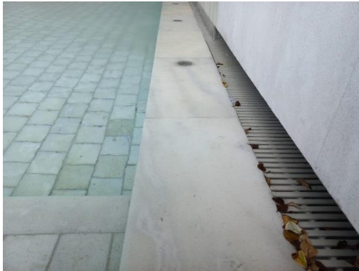
รูปที่ 21 รางระบายน้ำล้นสระว่ายน้ำ
