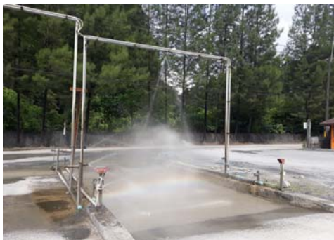
(7) ระบบฉีดล้างล้อและฉีดพรมหินก่อนออกจากโรงโม่หิน
