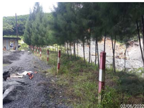
(5) เสาคอนกรีตค้ำขาแขวงพร้อมลวดหนามบริเวณขอบบ่อเหมือง
