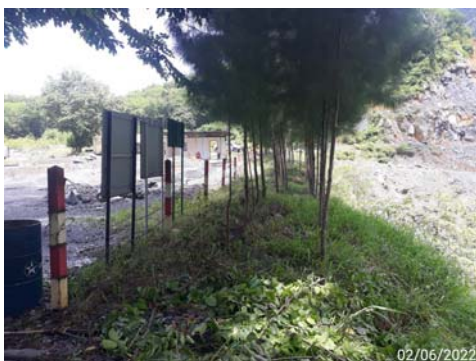
(2) ปลูกไม้ที่ปลูกไว้บริเวณขอบบ่อเหมืองป้องกันการพังทลาย
