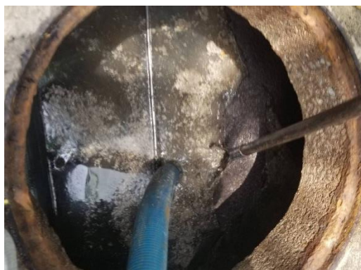
ดำเนินการสูบน้ำทิ้งระบบบำบัดน้ำเสีย
