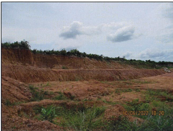
ภาพถ่ายที่ 2.3-11 การปรับความลาดเอียงของงานขุด/งานตัดดิน
