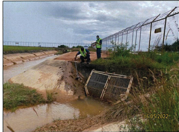
ภาพถ่ายที่ 2.3-12 การขุดลอกรางระบายน้ำแนวที่ 1 ภายใน ทกก.
