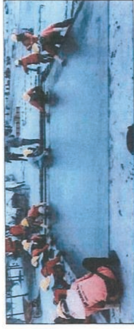
รูปแสดงการเก็บผิวหน้าทางดอมก๊รัดหลังทยอมก๊รัดเสร็จ
