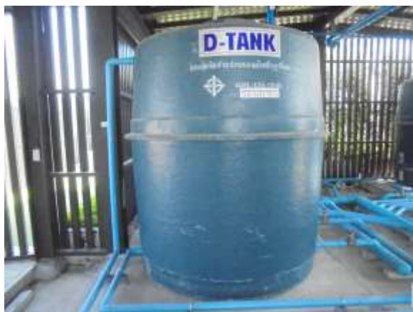
รูปที่ 11 ถังสำรองน้ำดับเพลิง
