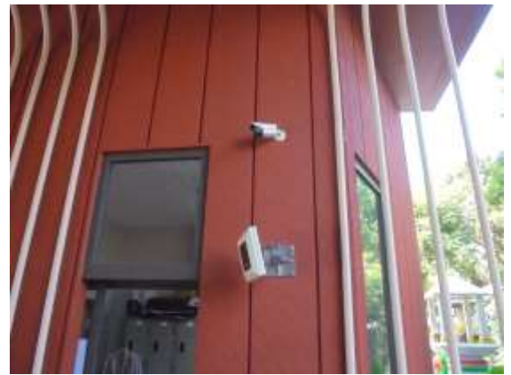
รูปที่ 28 ระบบโทรทัศน์วงจรปิด (CCTV System)
