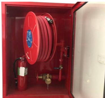
ภาพที่ 2-52 ตู้เก็บสายต่อน้ำดับเพลิงพร้อมอุปกรณ์ (FHC)
