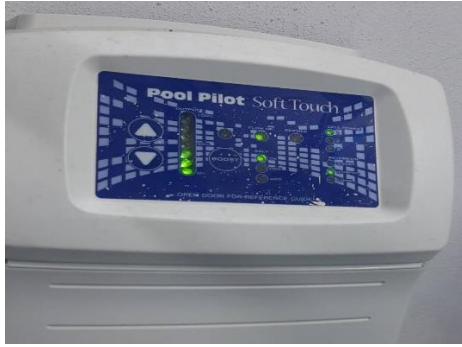
ภาพที่ 2-19 ระบบเกลือฆ่าเชื้อโรคในสระว่ายน้ำ
