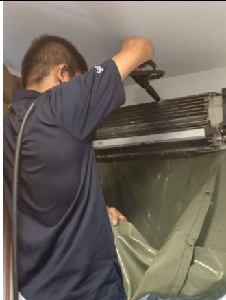
ภาพที่ 2-75 การล้างทำความสะอาดเครื่องปรับอากาศ
