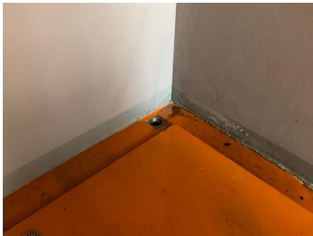
ภาพที่ 2-33 ท่อรวมน้ำจากห้องพักมูลฝอยรวม
