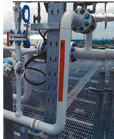
ภาพถ่ายที่ 2.2-30 ท่อส่งไนโตรเจนเข้า Pad ถังเก็บกัก
