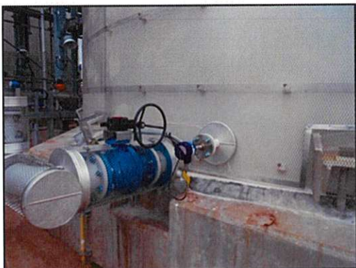
ภาพถ่ายที่ 2.2-35 อุปกรณ์ตรวจวัดอุณหภูมิของถังผลิตมันช์
