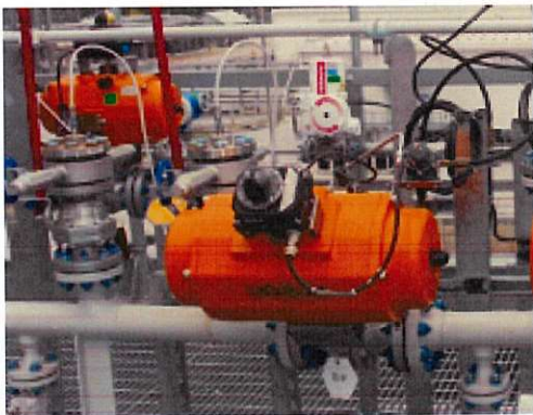
ภาพถ่ายที่ 2.2-33 ระบบ Automatic Block Valve ของ PO
