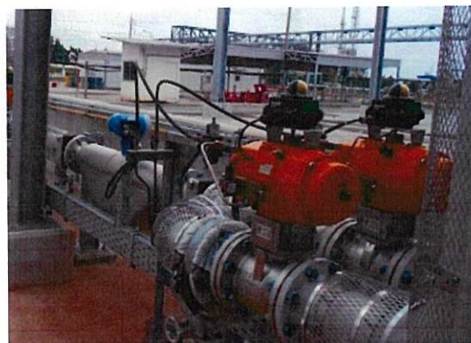
ภาพถ่ายที่ 2.2-34 อุปกรณ์ตรวจวัดในเส้นท่อน้ำ และ Isolate Valve
