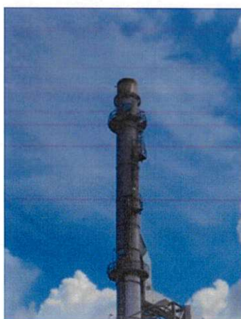
ภาพถ่ายที่ 2.2-2 หน่วยทำลายก๊าซและของเหลวที่เหลือจากการผลิต (TOX) ในความรับผิดชอบของ บริษัท ดาว เคมิคอล จำกัด (เดิม HPPO)
