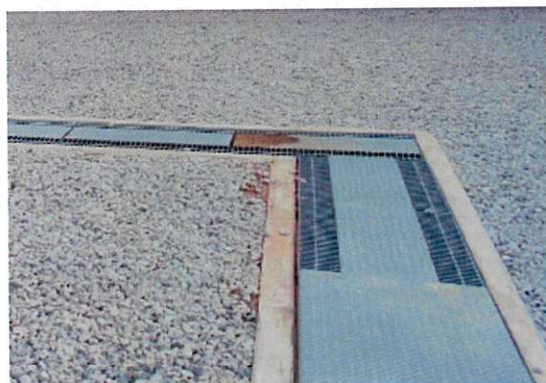
ภาพถ่ายที่ 2.2-6 รางระบายน้ำในพื้นที่ก่อนลงสู่บ่อท่วงน้ำ
