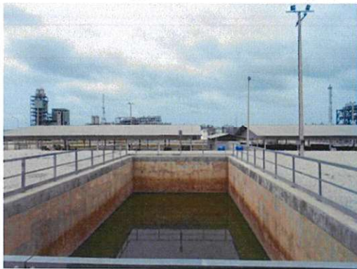
ภาพถ่ายที่ 2.2-9 บ่อพักน้ำฝนของโรงงานผลิต สารโพลิออลไกลคอล
