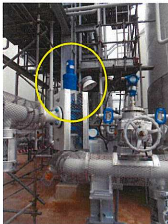
ภาพถ่ายที่ 2.2-29 อุปกรณ์ระบายความดันของถังเก็บ ผลิตภัณฑ์ (PSV)
