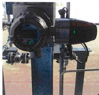
ภาพถ่ายที่ 2.2-32 Flow Meter ของถังปฏิกริยา
