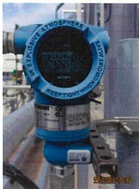
ภาพถ่ายที่ 2.2-31 อุปกรณ์ตรวจวัดอุณหภูมิและความดัน
