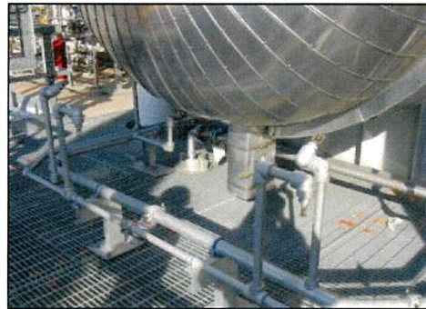
ภาพที่ 2.2-29 หัวฉีดน้ำดับเพลิง (Monitor gun) และหัวจ่ายน้ำพ่นฝอย (Deluge sprinkler)
