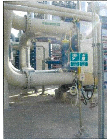
ภาพที่ 2.2-27 อ่างล้างตาและร่างกายฉุกเฉิน
