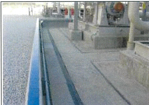
ภาพที่ 2.2-28 คันคอนกรีตล้อมรอบบริเวณที่มีการเก็บกักสารเคมี
