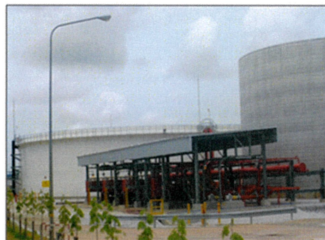
ภาพที่ 2.2-30 ถังเก็บกักน้ำสำรองเพื่อการดับเพลิง และปั้มน้ำดับเพลิง
